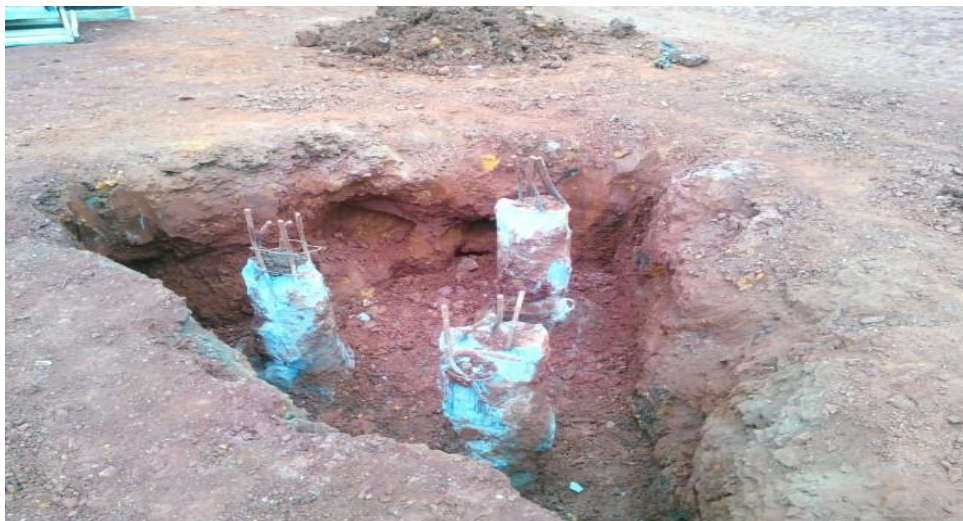
Figura 4 – Bloco escavado com as estacas raízes a mostra. Fonte: Autoria Própria.
