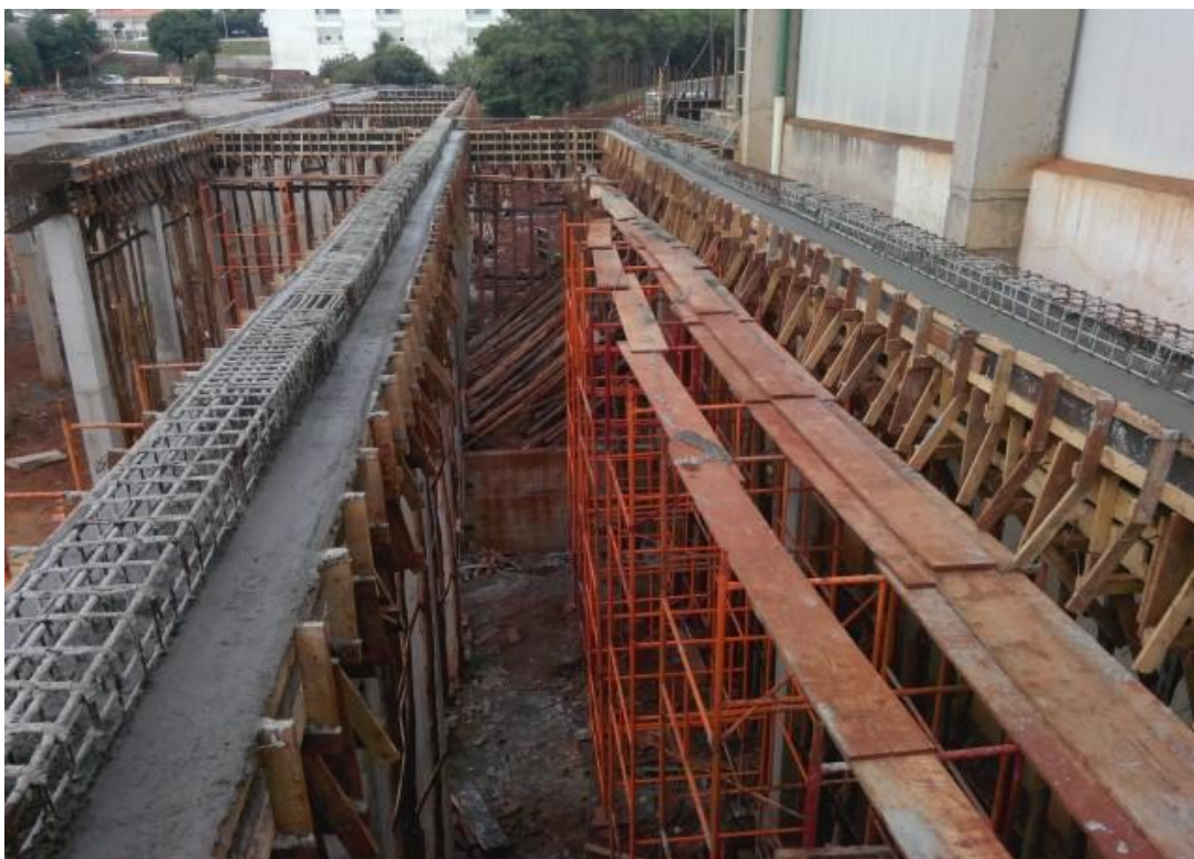
Figura 8 – Concretagem das vigas até a altura do consolo. Fonte: Autoria Própria.
