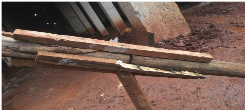
Figura 16 – Eucalipto emendado sendo reutilizado como prumo de pilares. Fonte: Autoria Própria.
