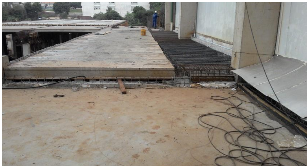
Figura 9 – No lado esquerdo da imagem se encontra a laje alveolar posicionada sobre os consolos, ao lado direito esta a armadura da laje maciça. Fonte: Autoria Própria.
