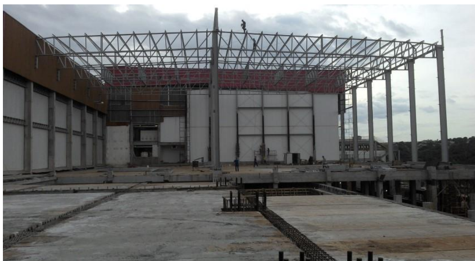
Figura 10 – Chumbadores no canto inferior da imagem e a estrutura metálica sendo montada ao fundo. Fonte: Autoria Própria.
