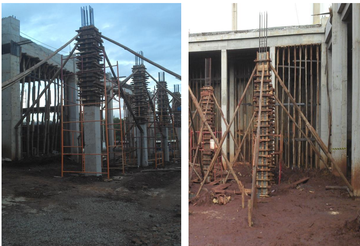
Figura 6 – Pilares já travados e prumados. Fonte: Autoria Própria.
