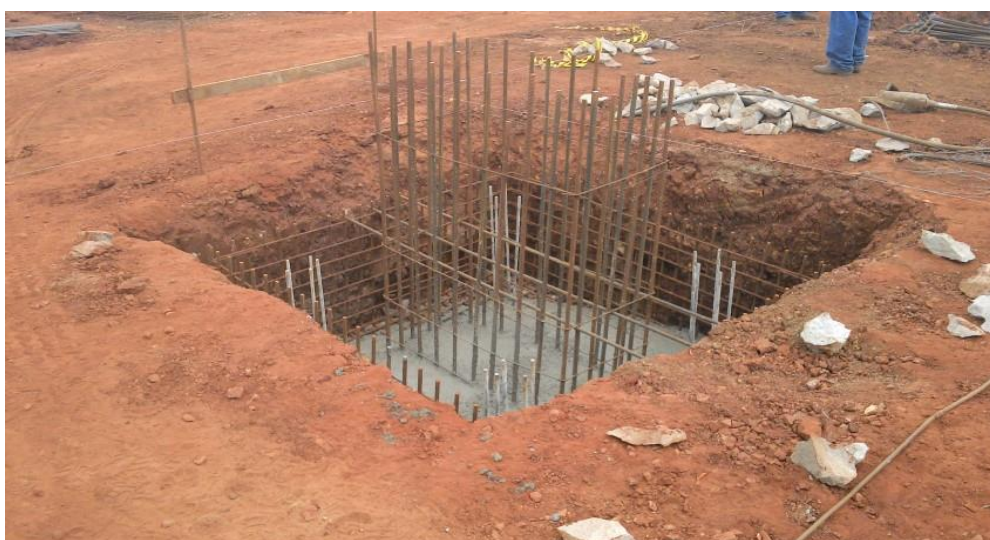
Figura 5 – Bloco estrutural com armadura posta e arranques prontos. Fonte: Autoria Própria.
