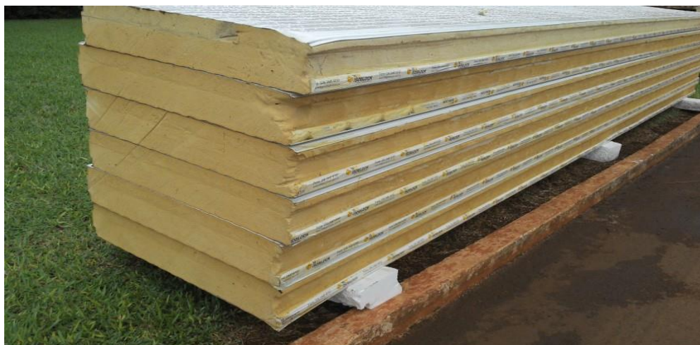
Figura 12 – Painéis (PIR) estocados no canteiro de obra. Fonte: Autoria Própria.
