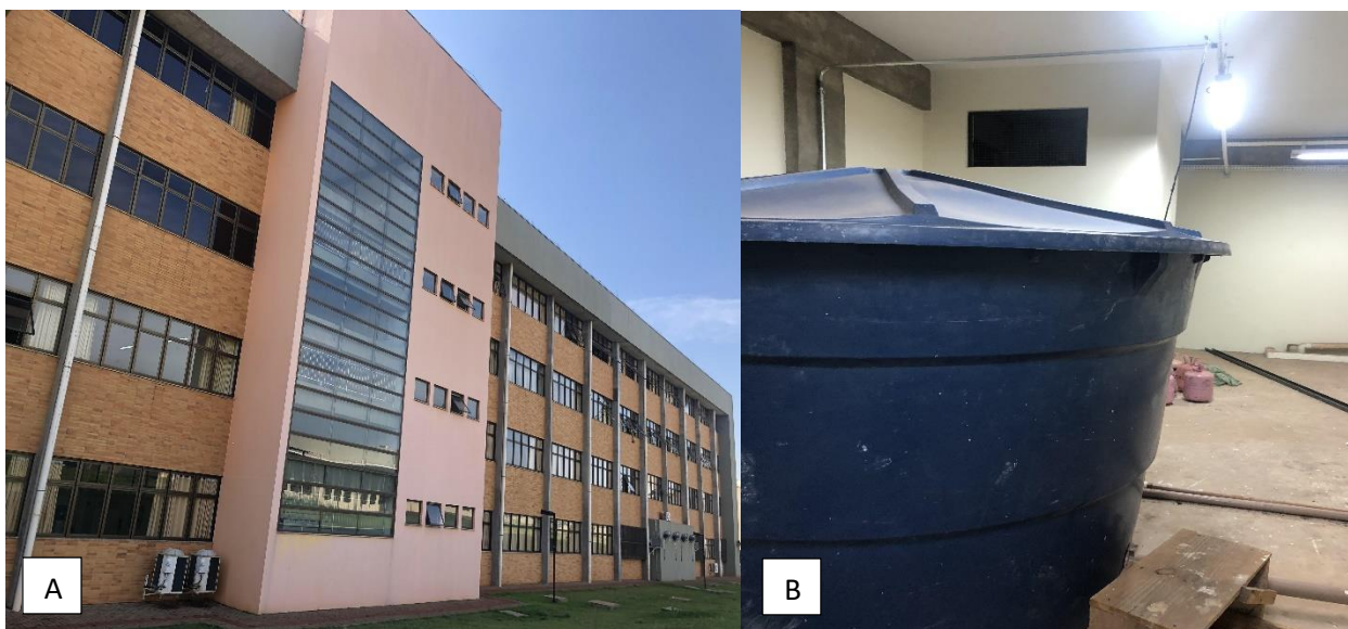
Figura 4: A - Fotografia do bloco K com o tubos de queda de águas pluviais Campus UTFPR – Campus Londrina; B – Fotografia do reservatório de água superior do bloco k.
