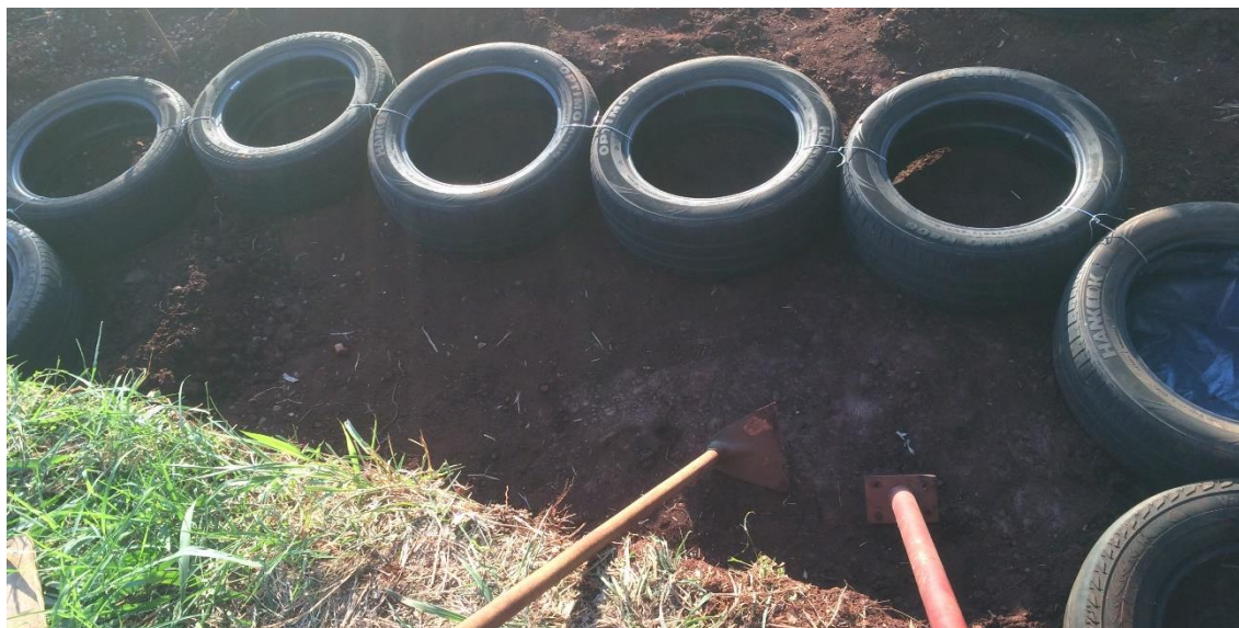
Figura 18 – Fotografia do primeiro nível de pneus Fonte: Aatoria Própria (2016).
