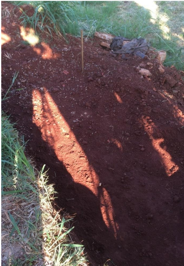
Figura 17 – Fotografia do local de construção do WCH
