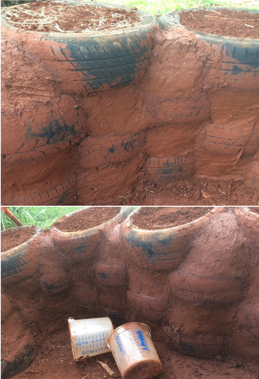
Figura 21 – Fotografia da calafetação interna dos pneus Fonte: Autoria Própria (2016).
