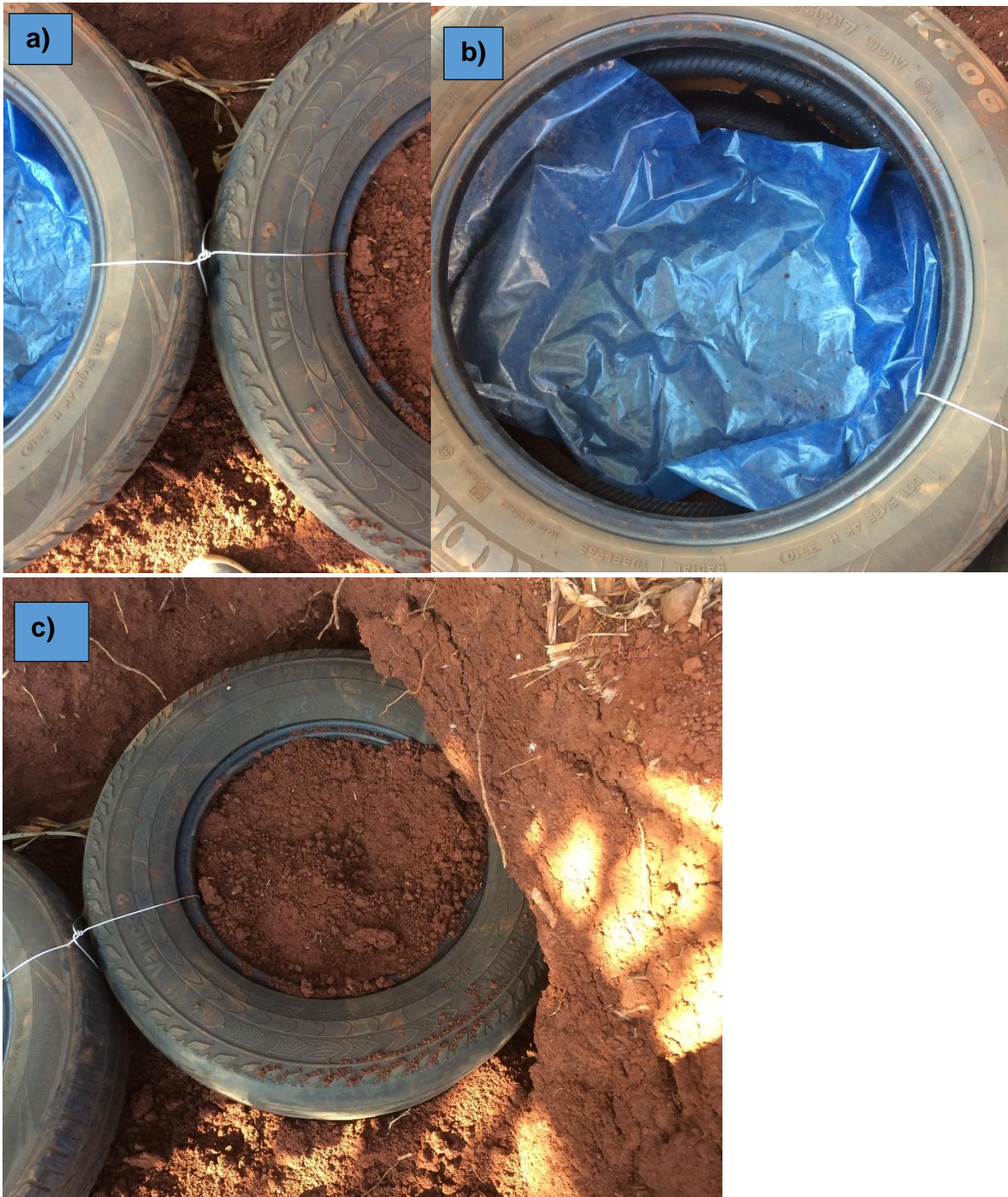
Figura 19 – Fotografia dos pneumáticos: (a) Amarra dos pneus com arame; (b) Forramento interno do pneu e (c) Preenchimento com terra e ancoragem da camada inferior ao talude Fonte: Autoria Própria (2016).
