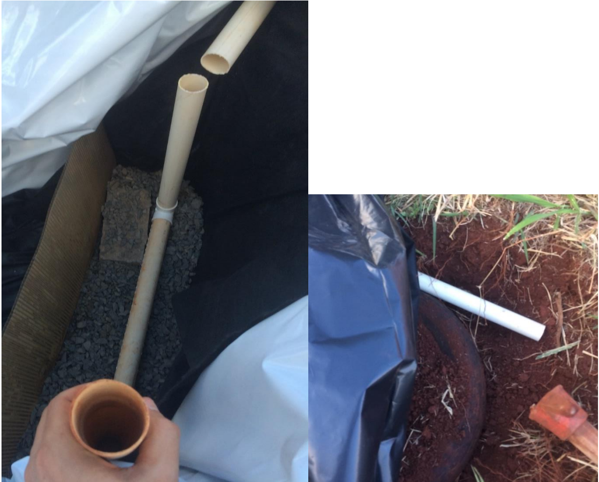
Figura 24 – Fotografia da saída do efluente do sistema: (a) coletor de efluente do WCH e (b) cano de saída de efluente
