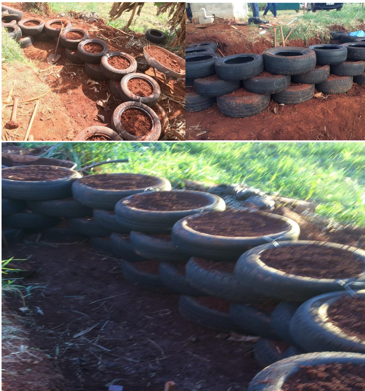
Figura 20 – Fotografia da segunda, terceira e quarta camada de pneus (de cima para baixo, da esquerda para a direita, respectivamente)
