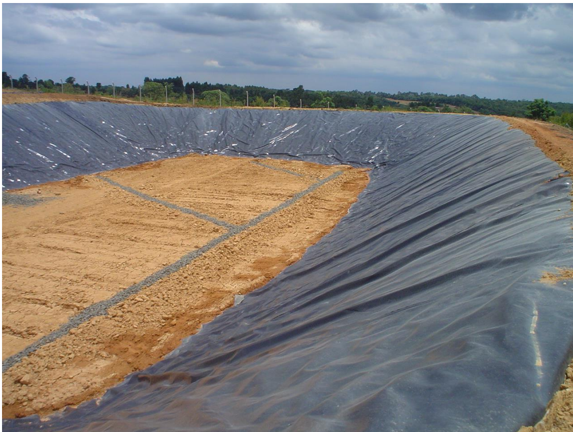
Figura 6 - Construção de um aterro sanitário. Fonte: Bidoni, 1999
