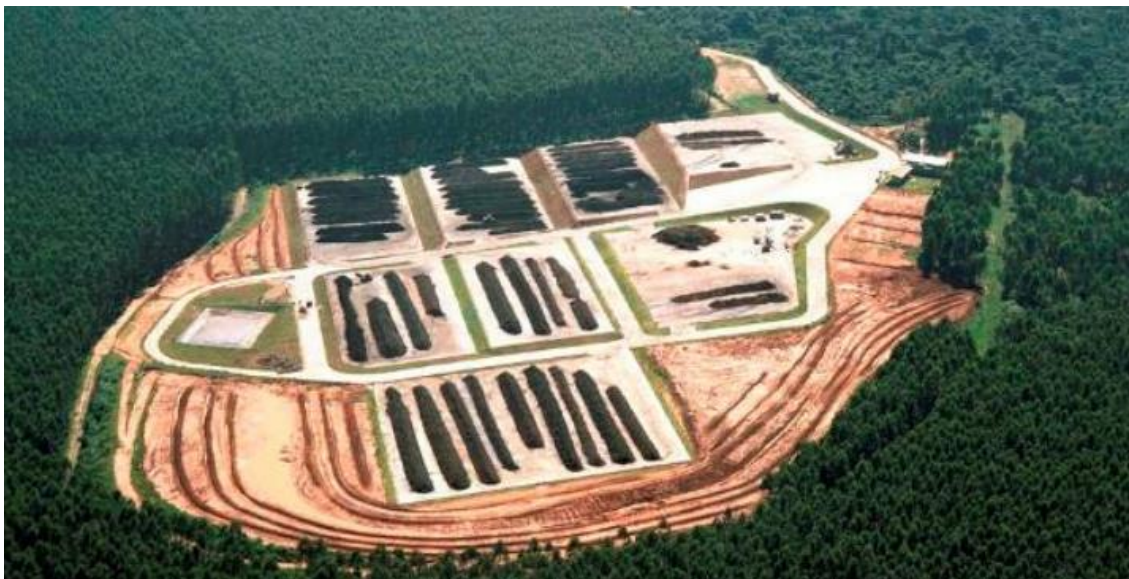
Figura 1 - Central de Compostagem. Fonte: Conpacel, 2009
