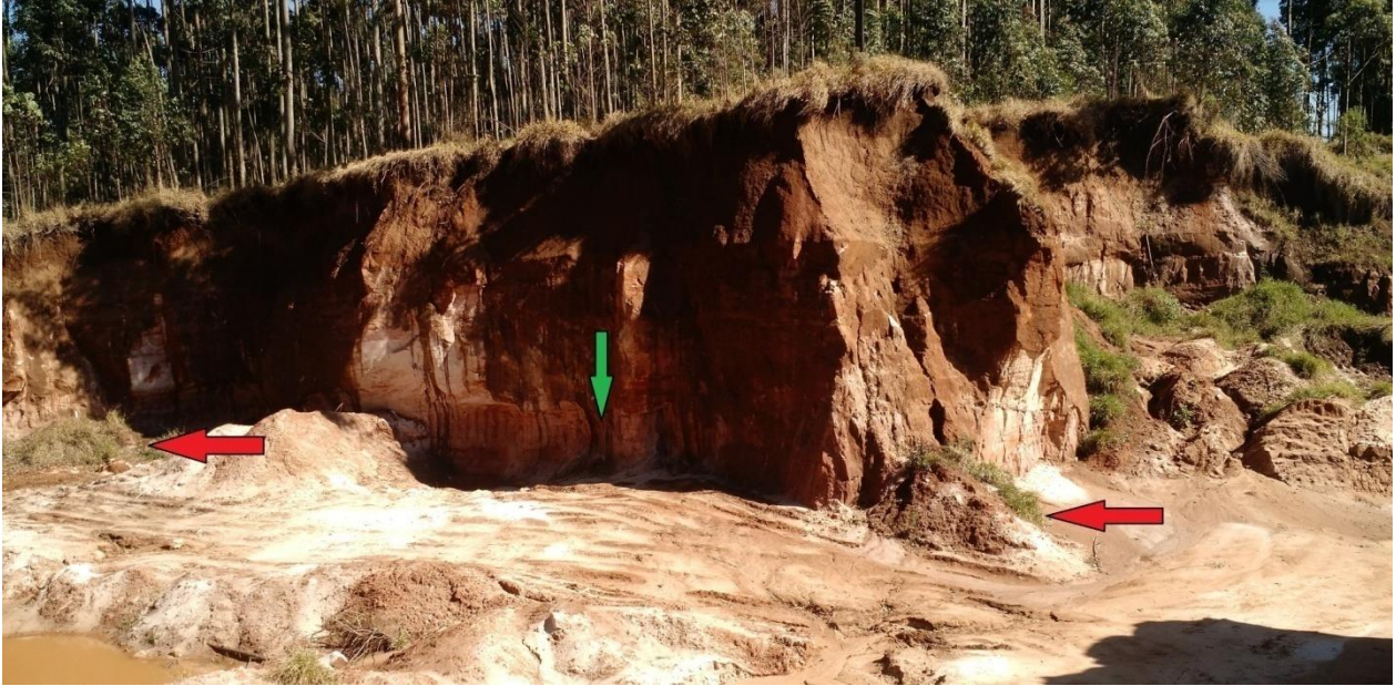
Figura 14 - Área de extração com talude instável, onde a seta verde indica a estaca n° 8 e as setas vermelhas indicam os acúmulos de origem de escorregamentos.
