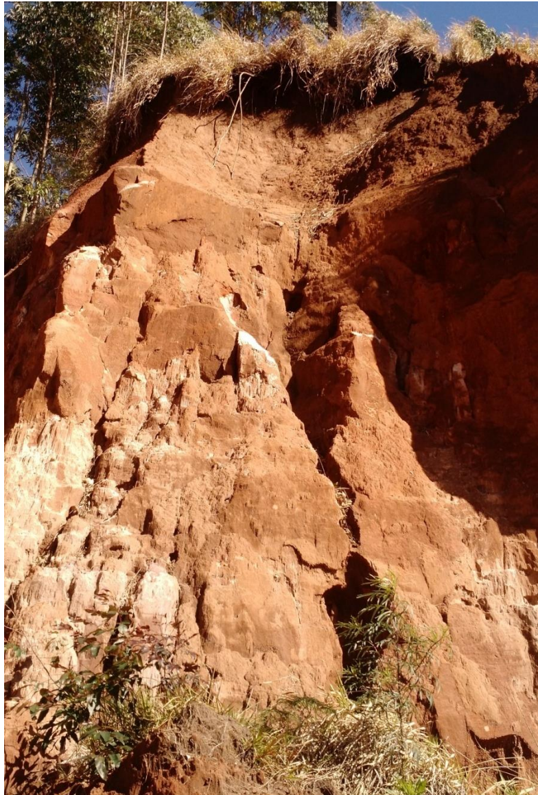
Figura 21 - Vista do talude onde ocorreu movimentação do solo, apresentando cicatrizes de escorregamento.
