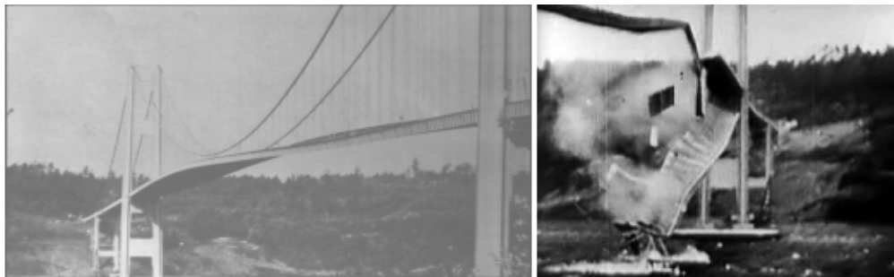
Figura 2 - Ponte de Tacoma em modo de ressonância torcional Fonte: GRECO
