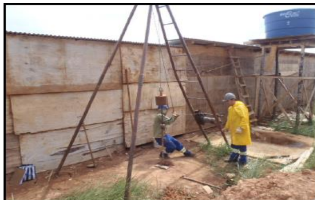
Figura 1 – Sondagem SPT executada pela empresa Rocha Sondagens
