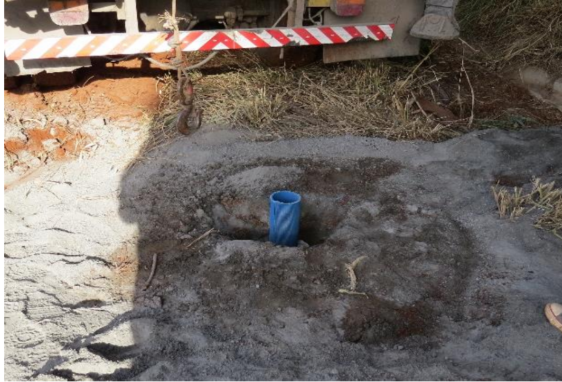
Figura 7: Poço finalizado com revestimento
