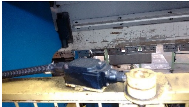
Figura 28 – Intertravamento do tipo eletromecânico na parte posterior da máquina.
