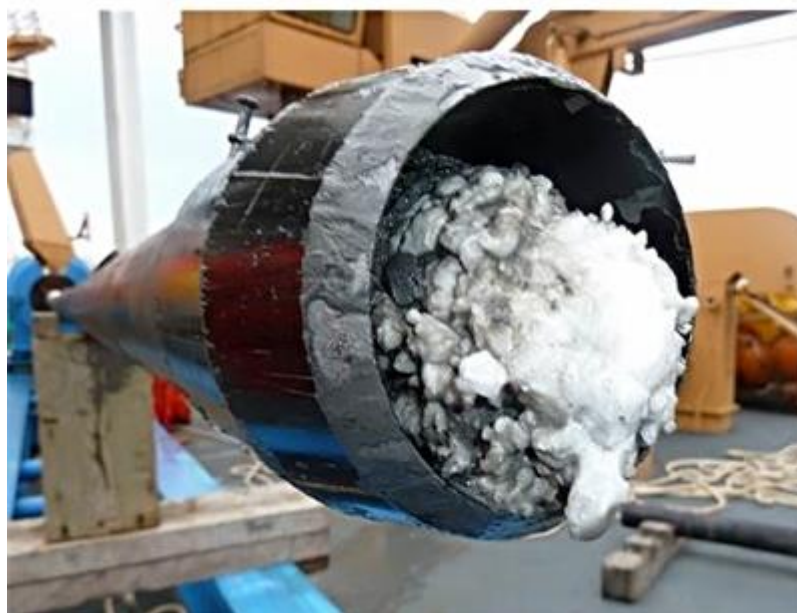
Figura 2 - Remoção de um plugue de hidrato de uma tubulação.
