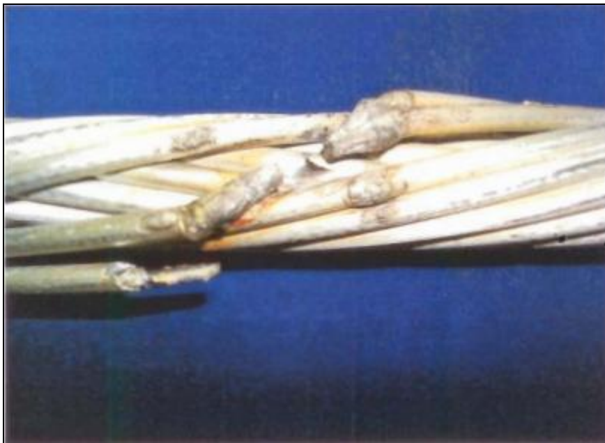
Figura 54 – Detalhe do cabo após o ensaio nº 5. Fonte: DLA-9876/2013.
