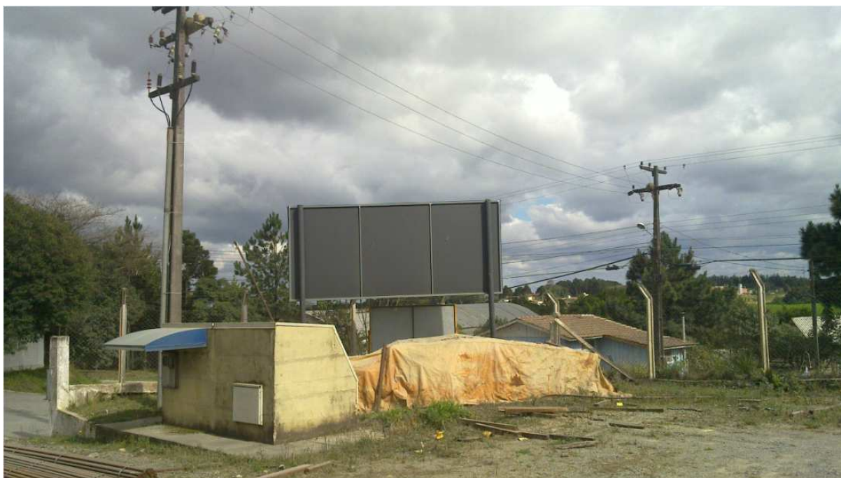
Figura 26 – Detalhe da Entrada de Energia
