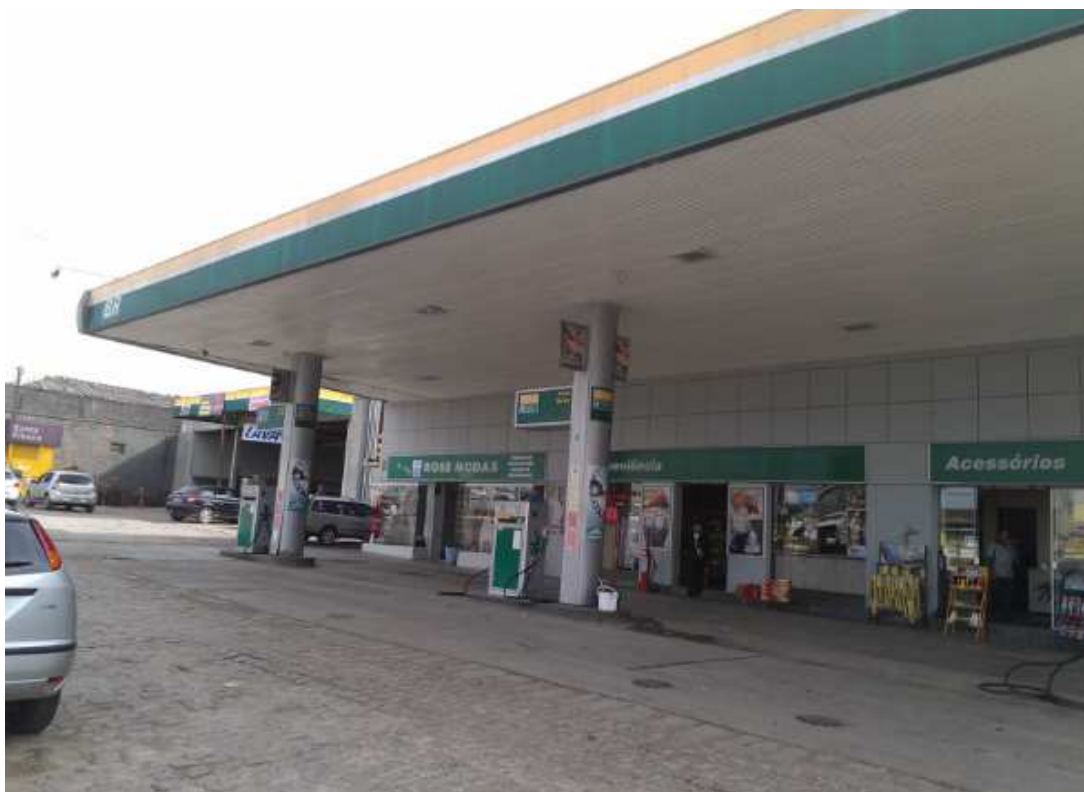
Figura 30– Vista do posto de combustível.
