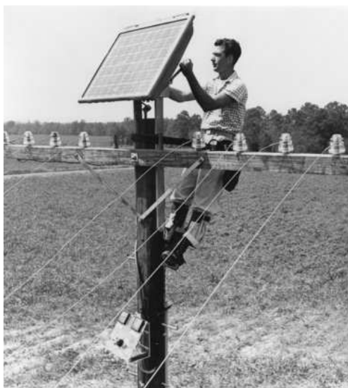
Figura 2 – Instalação do primeiro painel solar. EUA, em 1955.
