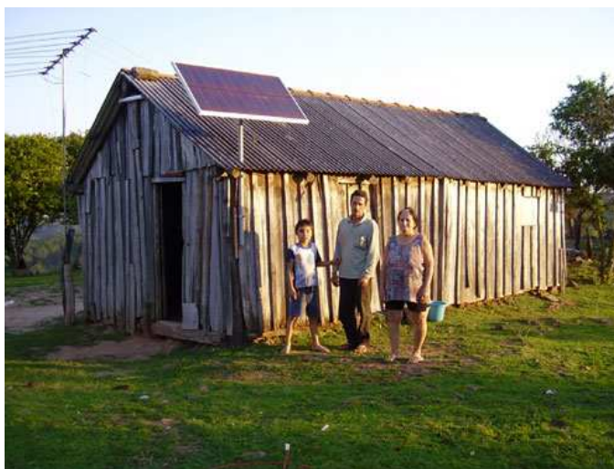
Figura 14 – Sistema isolado instalado em uma residência rural.
