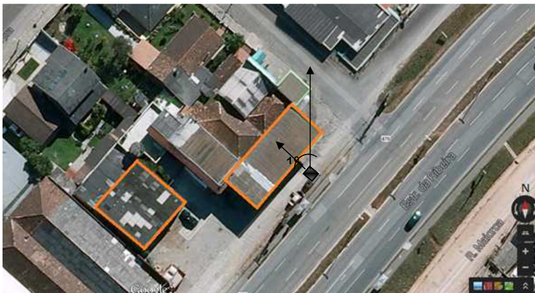
Figura 32- Vista superior da cobertura do posto e da área anexa.
