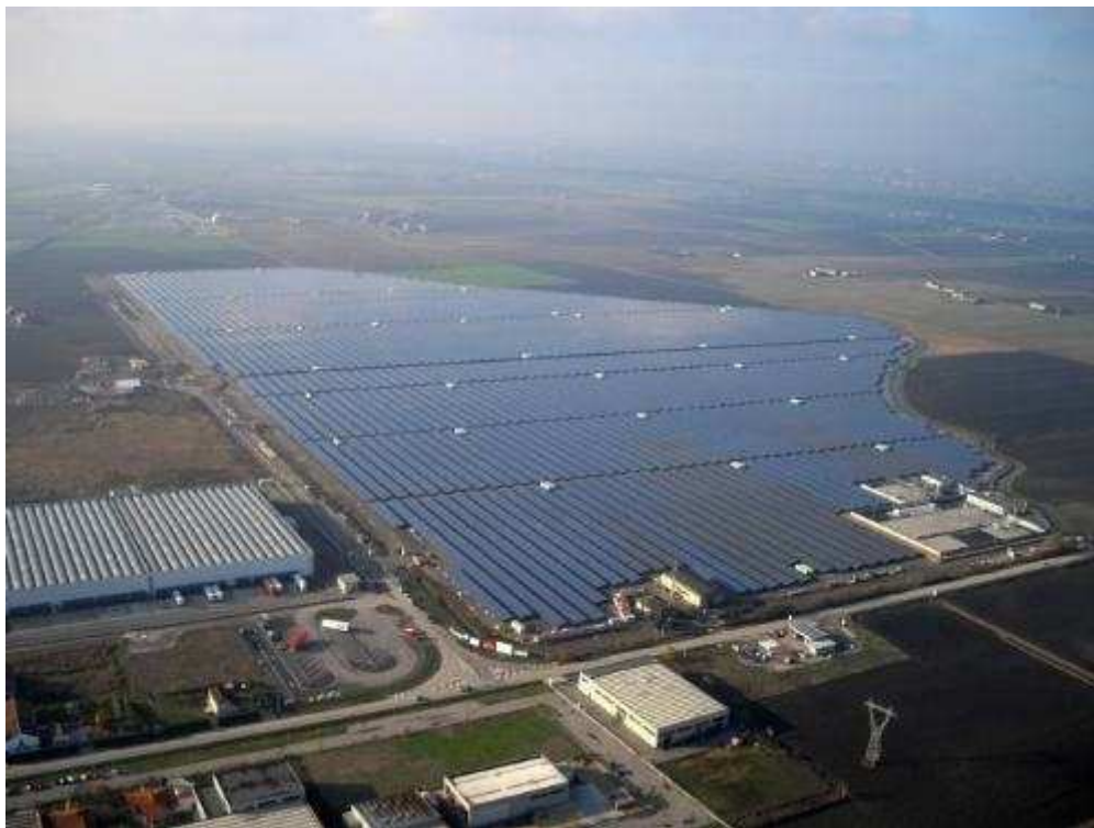
Figura 17 – Usina solar com capacidade para gerar 70 MW em Rovigo, Itália.
