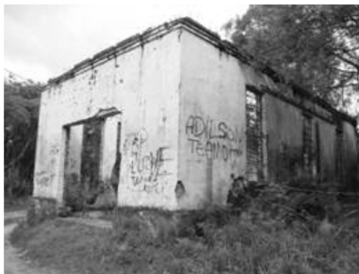
(a) – Casa de máquinas
