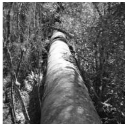
(b) – Conduto forçado
