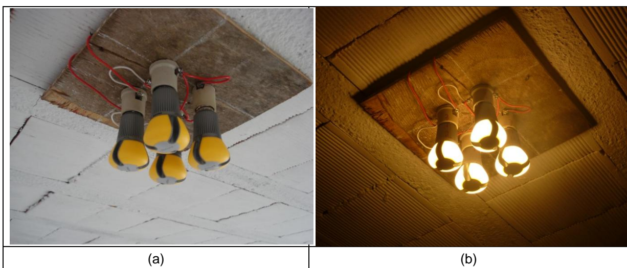
Figura 82 - Suporte construído para as lâmpadas e sua disposição - Lâmpadas LED (a) desligadas e (b) ligadas. Fonte: Autoria própria.
