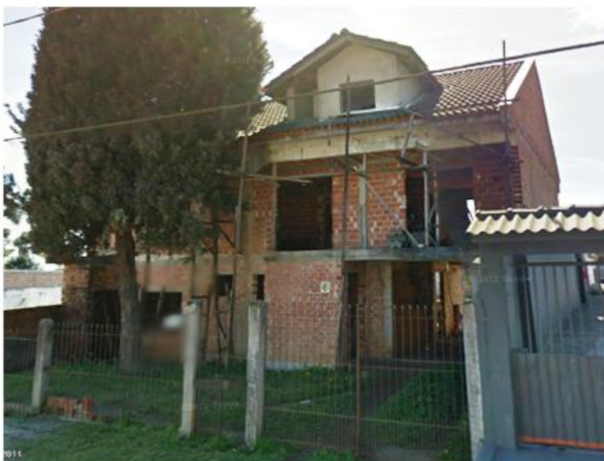
Figura 42 - Visão frontal da residência em construção. Fonte: Autoria própria.
