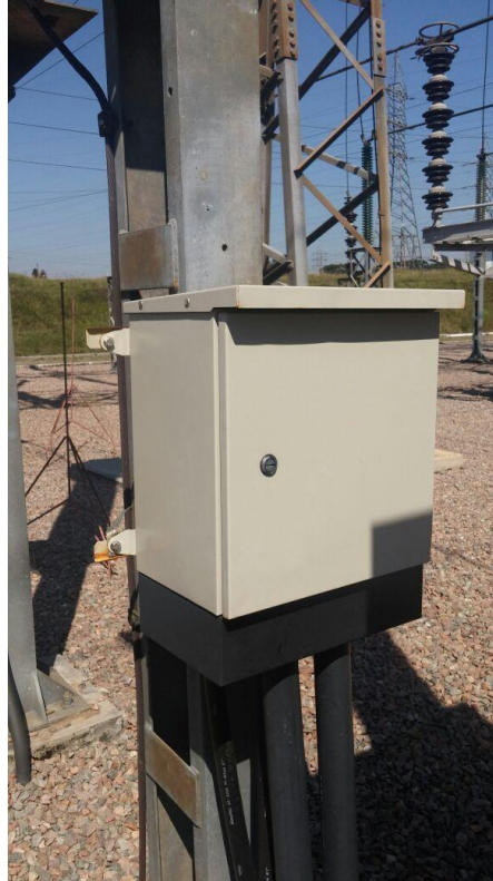
Figura 42 - DGO de pátio fechado instalado na base da fase A do TECO-MR. Fonte: Autoria própria (2016)
