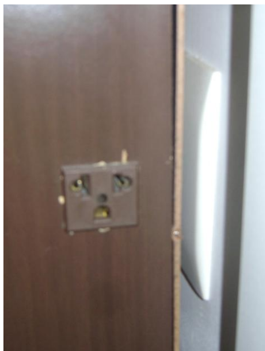
Figura 25 – Tomada inadequada
