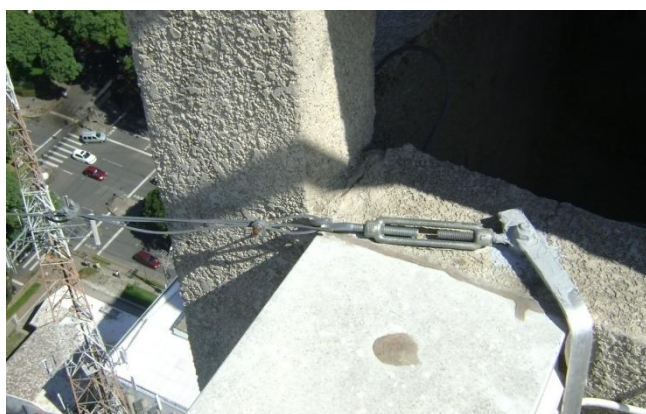
Figura 20 – Estais da chaminé
