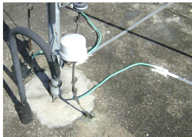
Figura 18 – Interligação da proteção de borda
