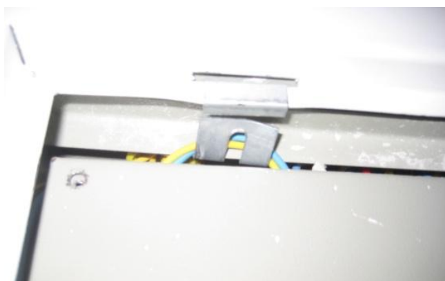
Figura 9 – Condutor em local inadequado no quadro
