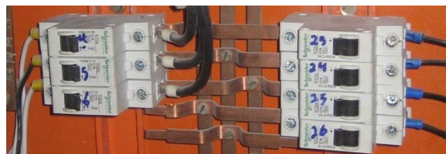
Figura 14 – Identificação dos dispositivos de proteção
