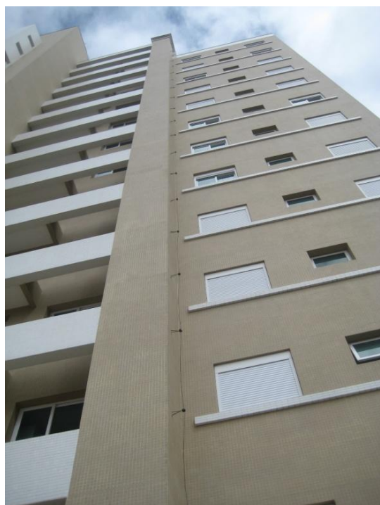
Figura 19 – Descida do SPDA
