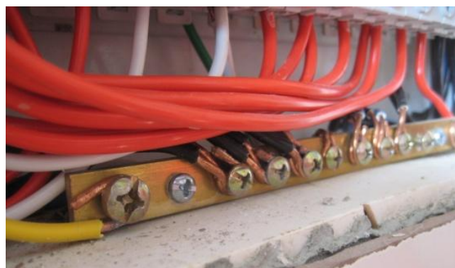
Figura 12 – barra de neutro
