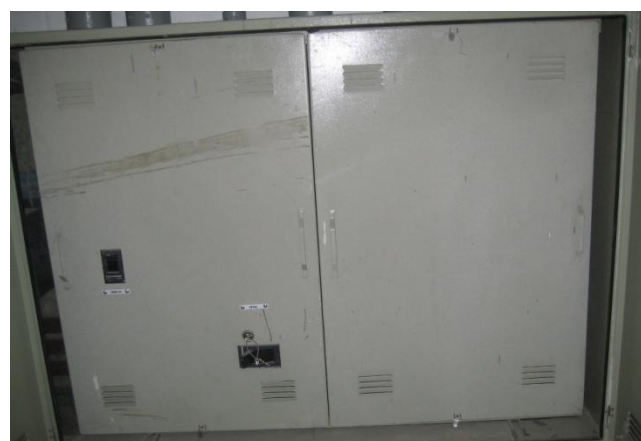
Figura 4 – Acesso ao barramento
