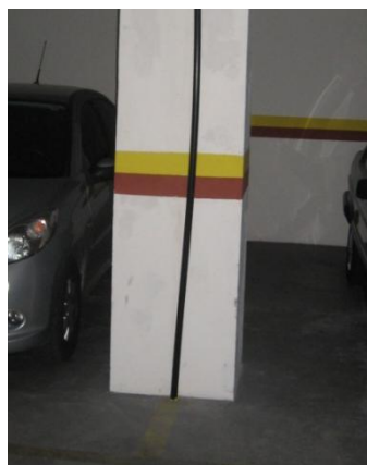
Figura 14 – Ausência das caixas de inspeção
