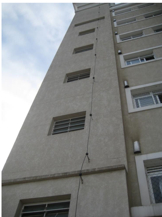
Figura 13 – Descida do SPDA
