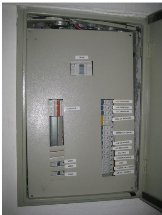
Figura 1 - Quadro condomínio B
