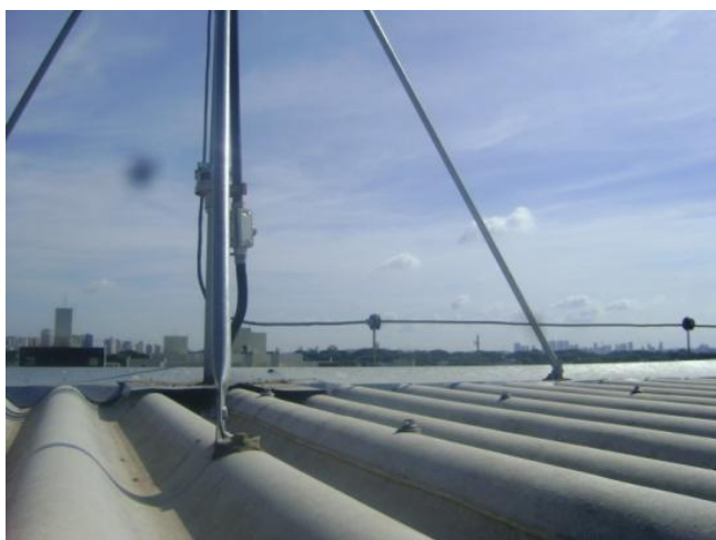
Figura 5 – Ligação do captor Franklin à única descida do SPDA
