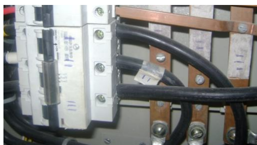
Figura 8 - Dispositivos alimentados por "jumpers"
