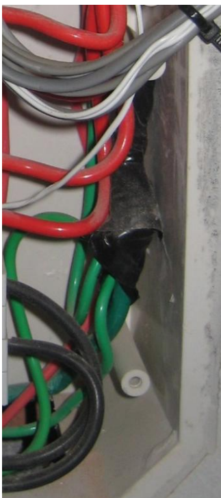
Figura 31 – Emenda entre condutores terra
