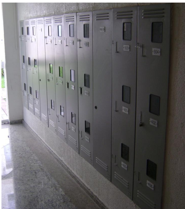
Figura 2 – Centro de medição
