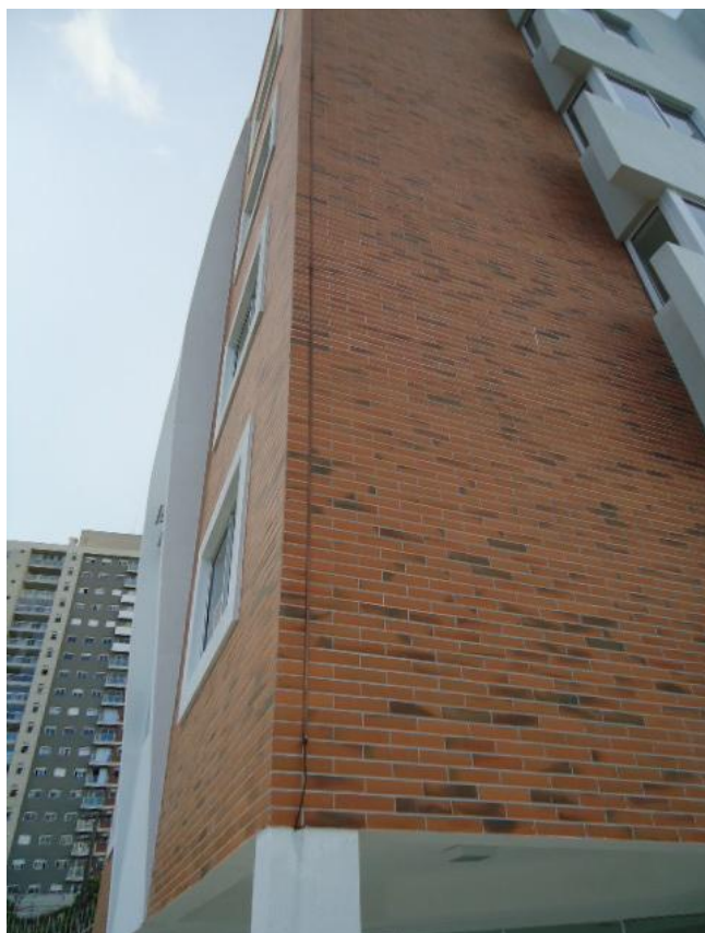
Figura 10 – Descidas do SPDA
