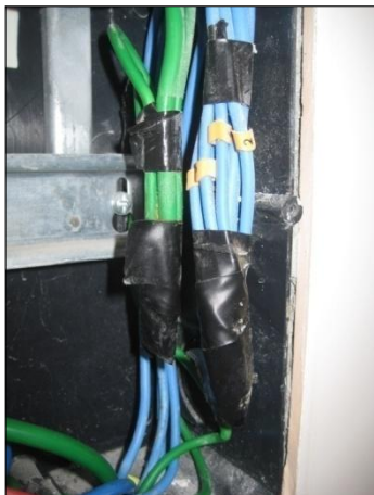
Figura 29 – Ausência de barra de terra Fonte: Os autores.
