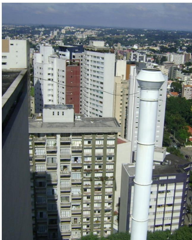
Figura 19 – Cabo da chaminé
