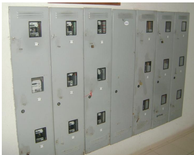
Figura 2 – Centro de medição
