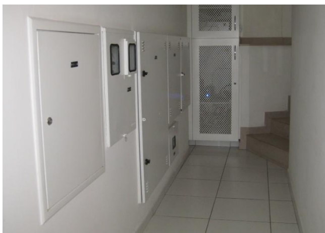
Figura 6 - Quadros da entrada de serviço
