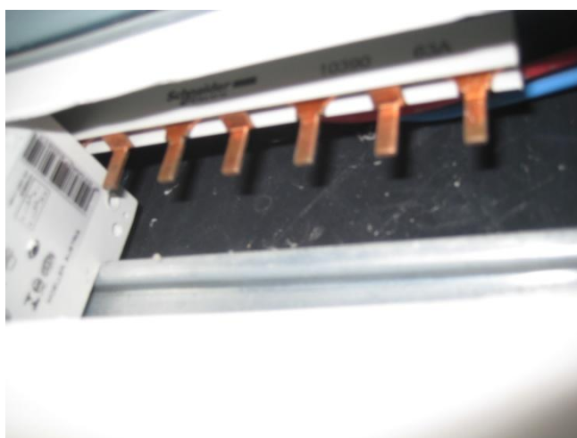
Figura 10 – Acesso ao barramento
