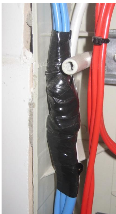
Figura 18 – Emenda entre condutores neutro
