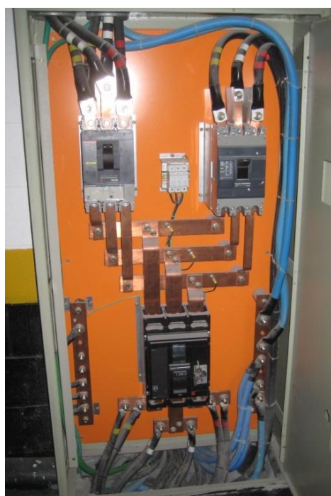
Figura 2 – Quadro Geral BT serviço sem espelho
