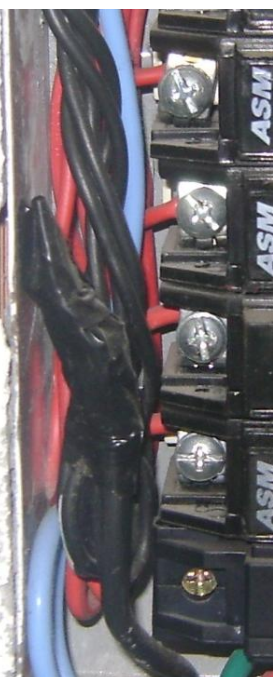
Figura 19 – Emenda entre condutores neutro
