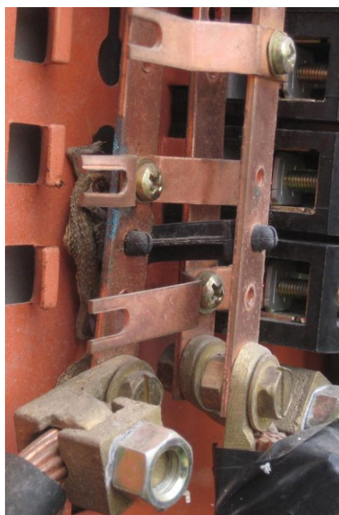
Figura 7 – Presença de lagartixa no barramento
