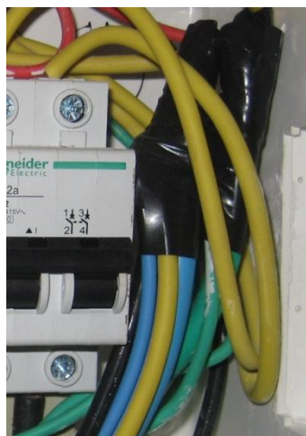
Figura 12 – Emenda de condutores neutro e terra
