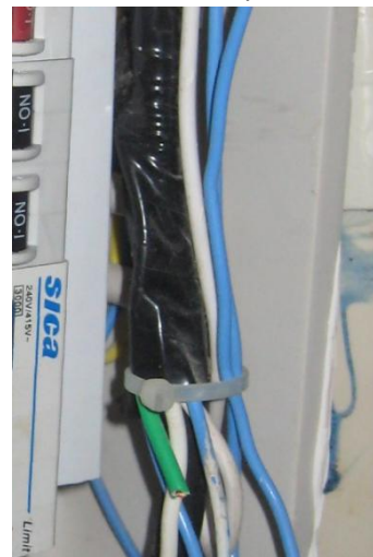
Figura 12 – Emenda entre condutores neutro
