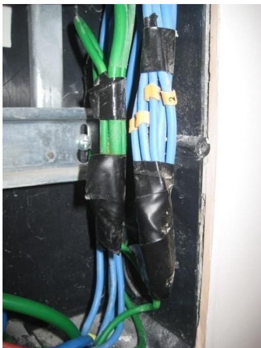
Figura 9 – Condutor neutro e terra
