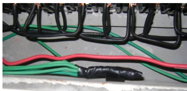
Figura 13 – Emenda entre condutores de aterramento
