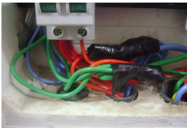
Figura 22 – Emenda entre condutores neutro e entre condutores terra
