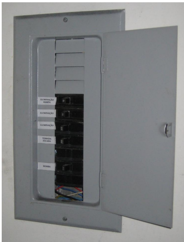
Figura 7 – Quadro de bombas e subsolo
