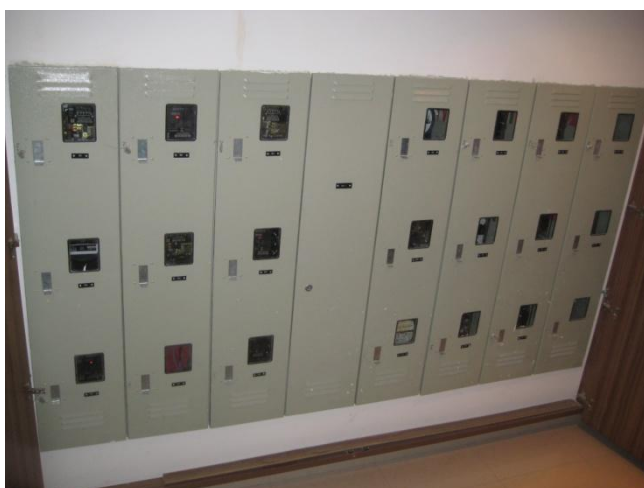
Figura 3 – Centro de medição
