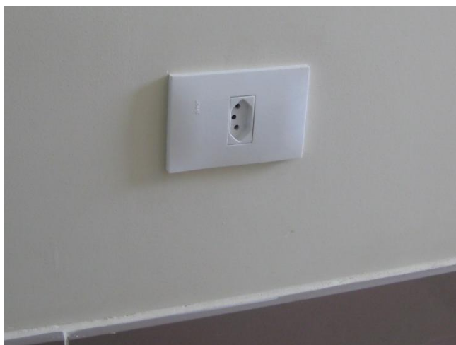
Figura 6 – Tomada do Hall de entrada
