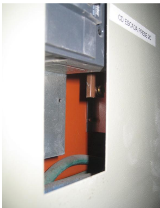
Figura 6 – Acesso ao barramento
