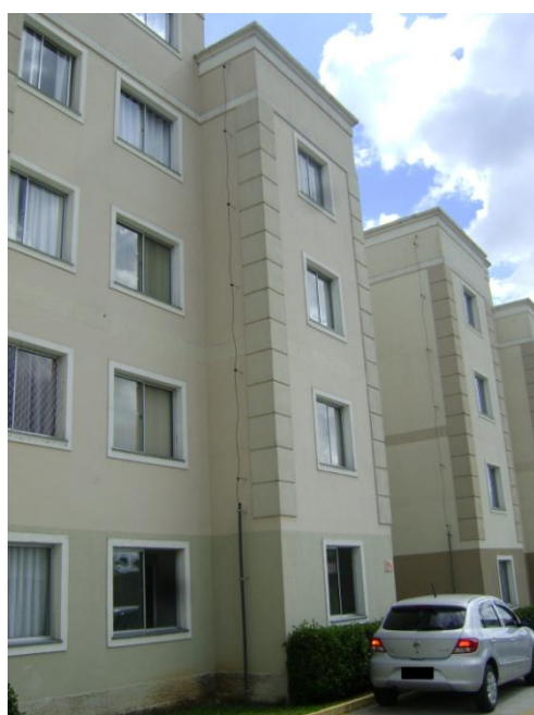
Figura 9 – Descida do SPDA
