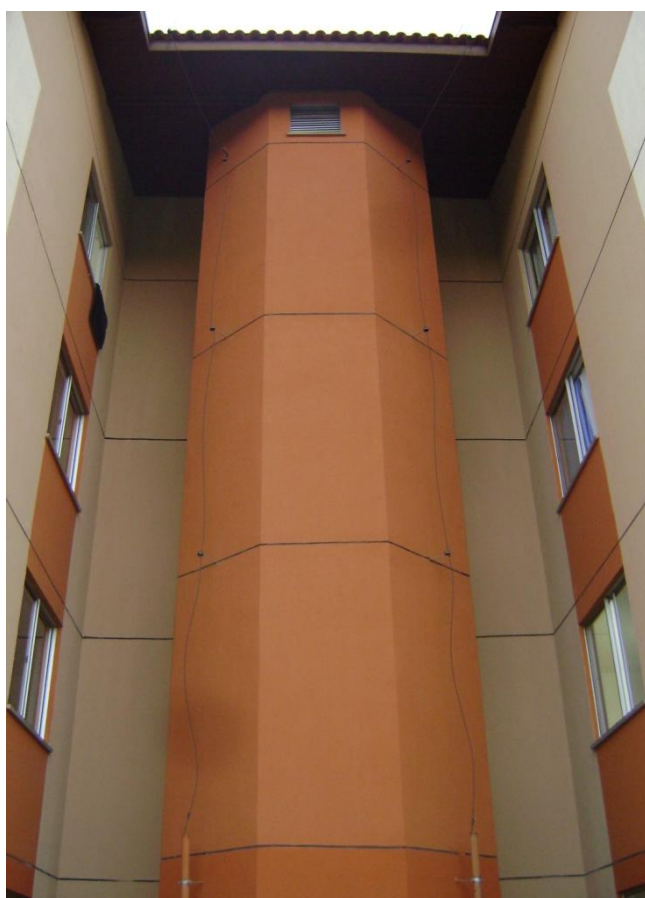
Figura 14 – Descidas do SPDA
