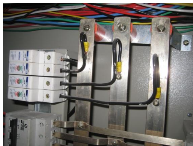
Figura 7 – Ligação de DPS com barramento
