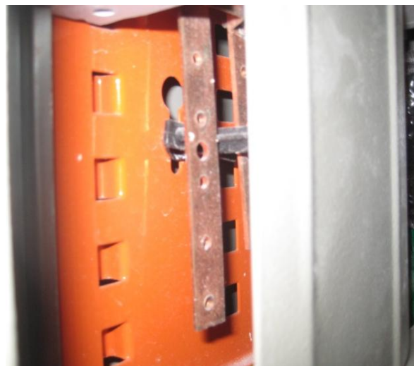
Figura 12 – Acesso ao barramento
