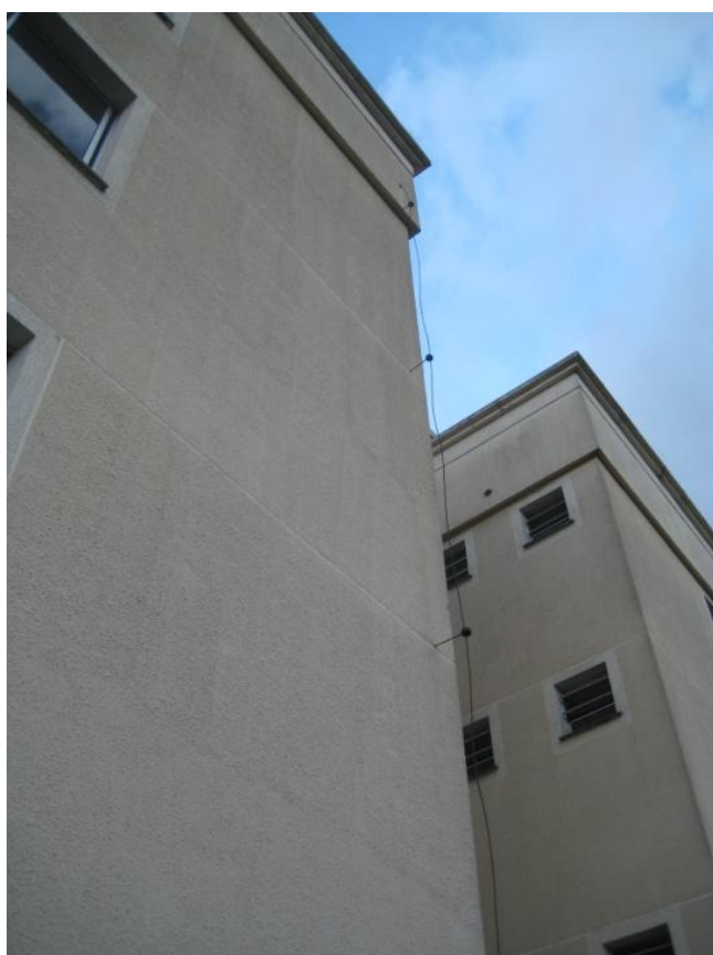
Figura 26 – Descida única de SPDA de um bloco
