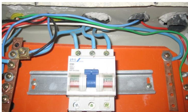
Figura 6 – Condutor azul claro nas fases
