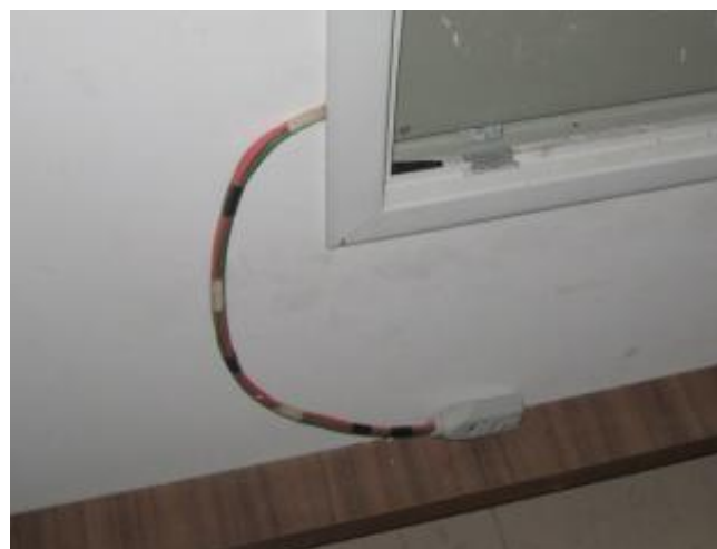
Figura 11 – Tomada inadequada
