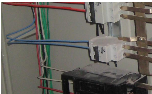
Figura 4 – Conductor azul claro utilizado a fase
