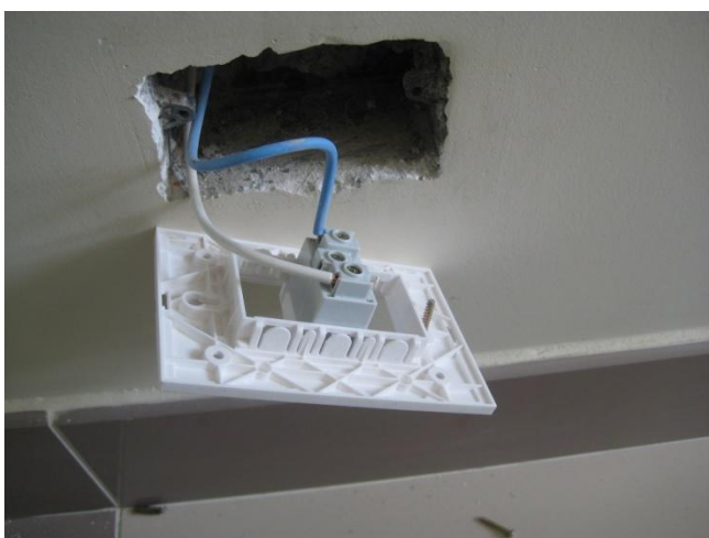
Figura 7 – Tomada do Hall de entrada aberta
