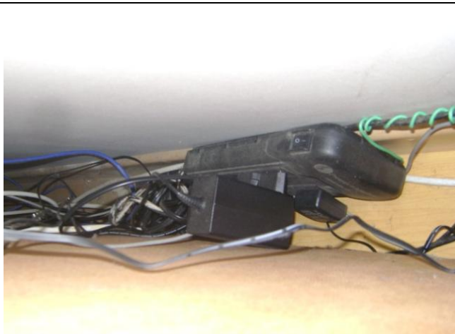
Figura 14 – Tomada na sala
