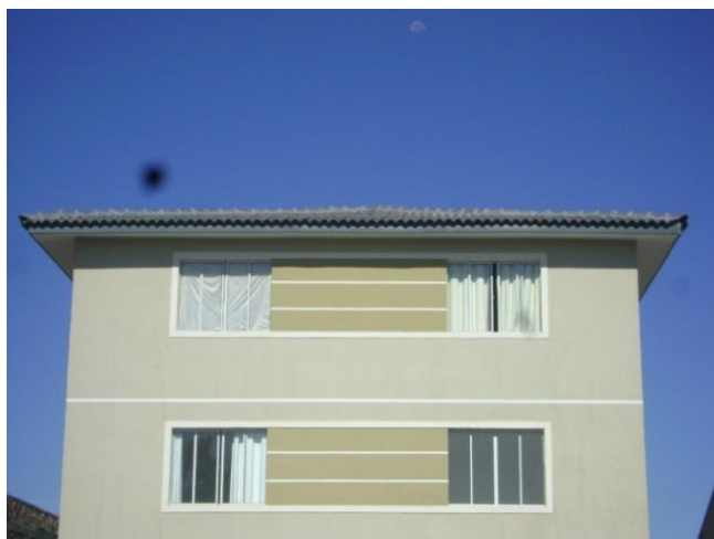
Figura 9 – Vista frontal do condomínio, sem a presença de SPDA
