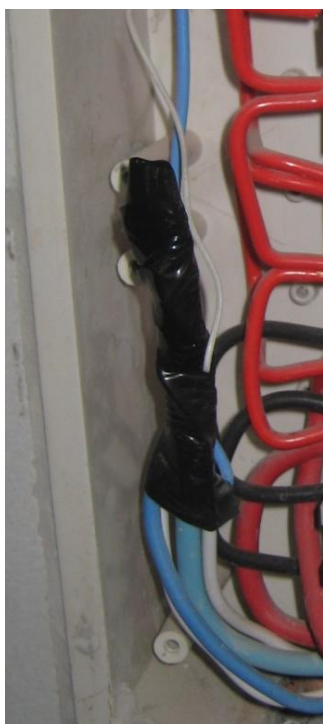
Figura 30 – Emenda entre condutores neutro
