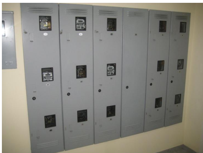
Figura 2 – Centro de medição
