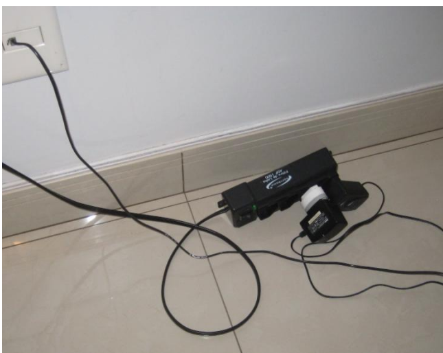
Figura 16 – Tomada em quarto
