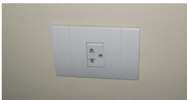
Figura 10 – Tomada com suposto aterramento
