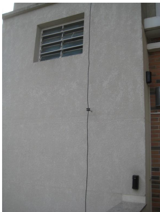
Figura 14 – Descida próxima a sacada
