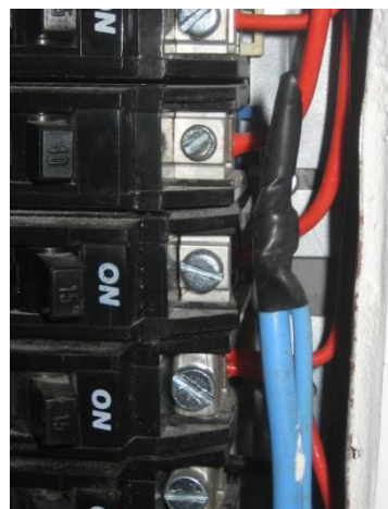
Figura 17 – Emenda entre condutores neutro.
