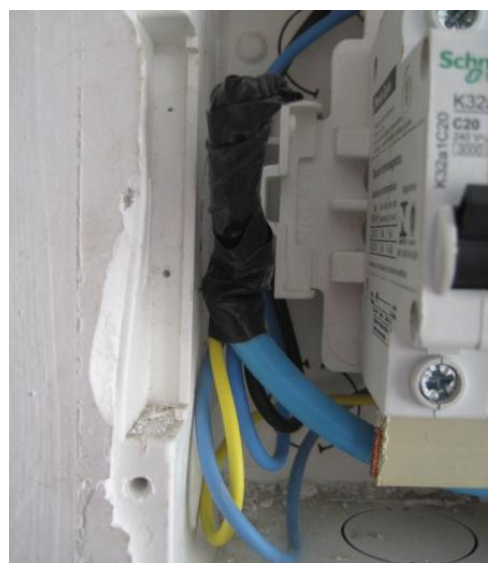
Figura 6 – Emenda de condutores neutro
