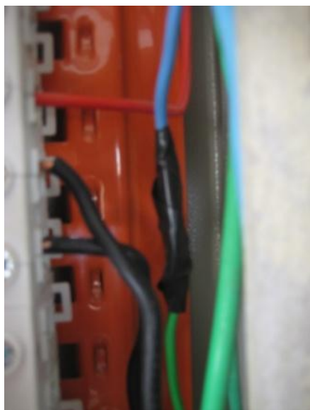
Figura 9 – Emenda de condutores de cores diferentes
