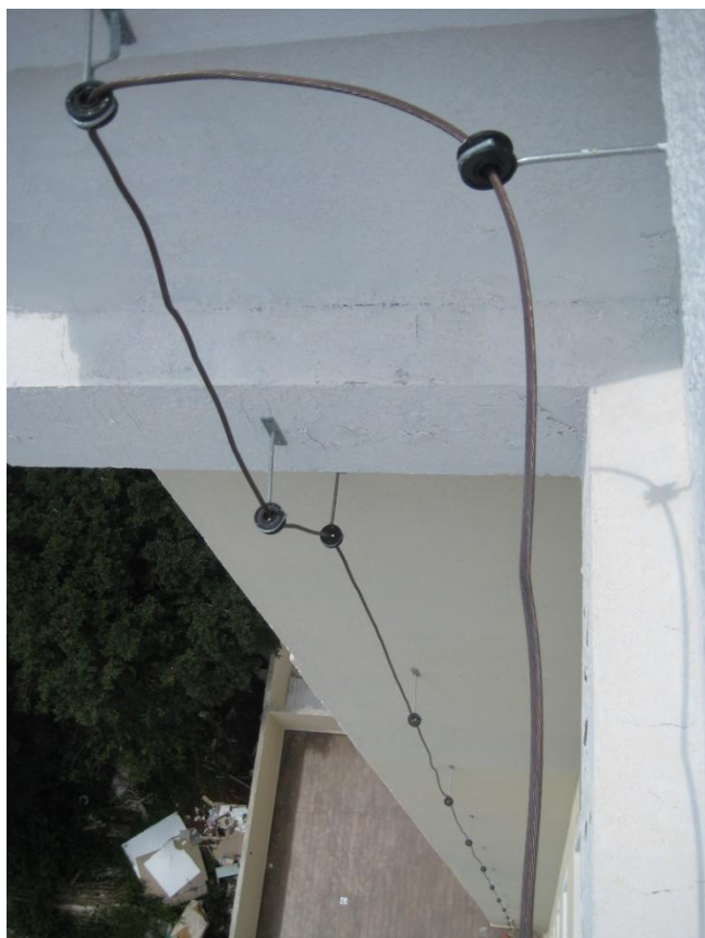
Figura 8 – Descida do SPDA
