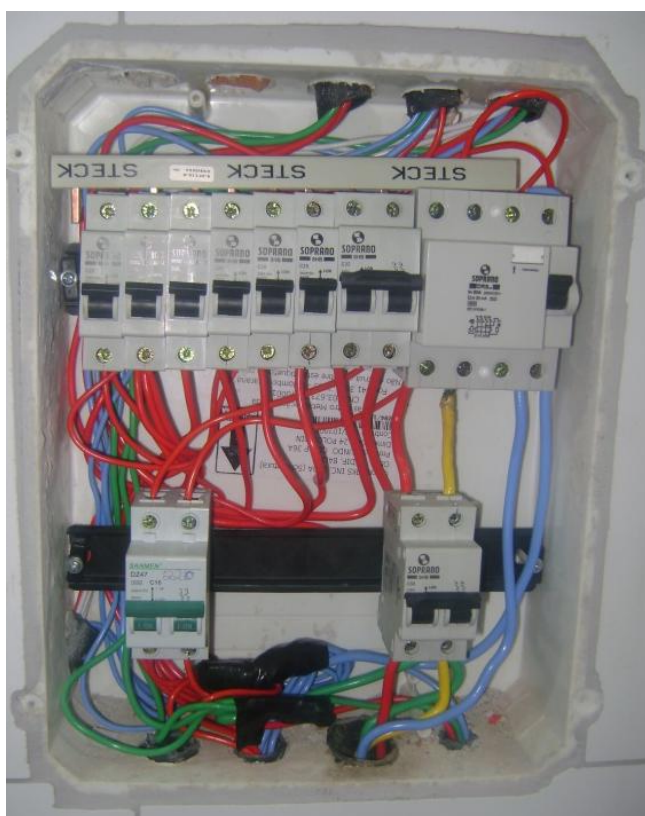
Figura 21 – Quadro de distribuição do salão apartamento sem espelho
