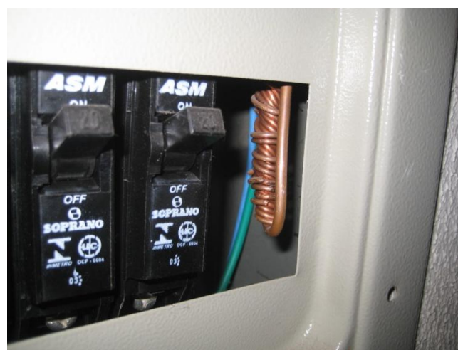
Figura 5 – Condutores expostos
