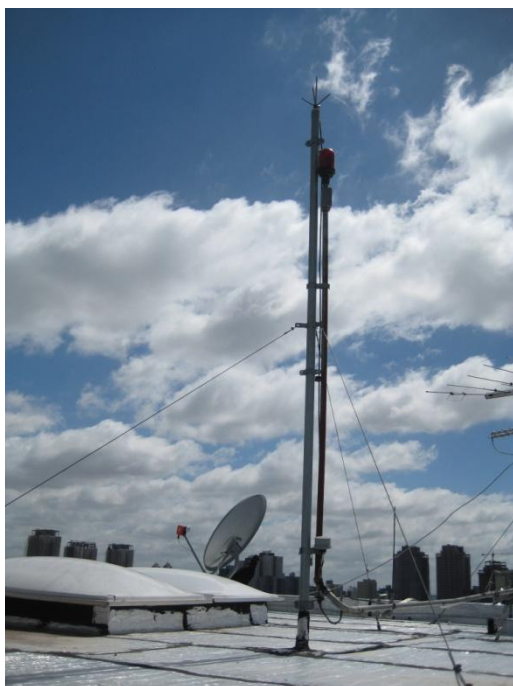
Figura 12 – Descidas do SPDA
