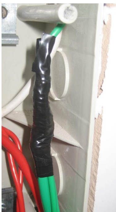
Figura 19 – Emenda entre condutores terra
