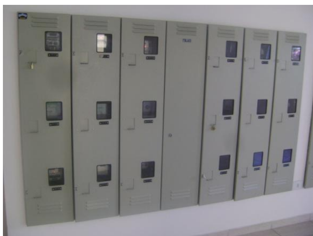
Figura 3 – Centro de medição
