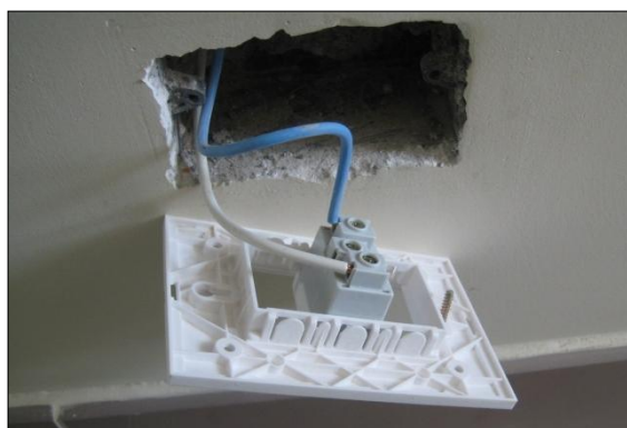
Figura 22 – Tomada sem o condutor terra Fonte: Os autores.
