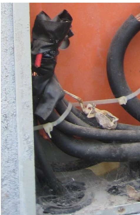
Figura 8 – Emenda entre condutores neutro
