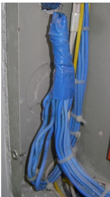
Figura 4 – Emenda entre condutores neutro
