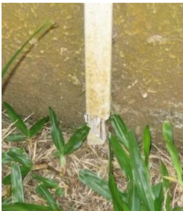
Figura 23 – Canaleta danificada
