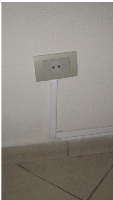
Figura 8 – Tomada do Hall de entrada
