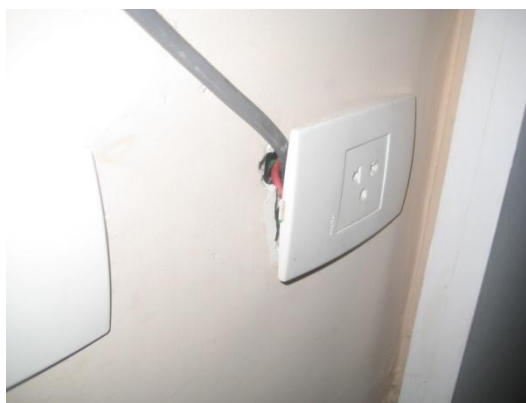
Figura 6 – Abertura do espelho da tomada
