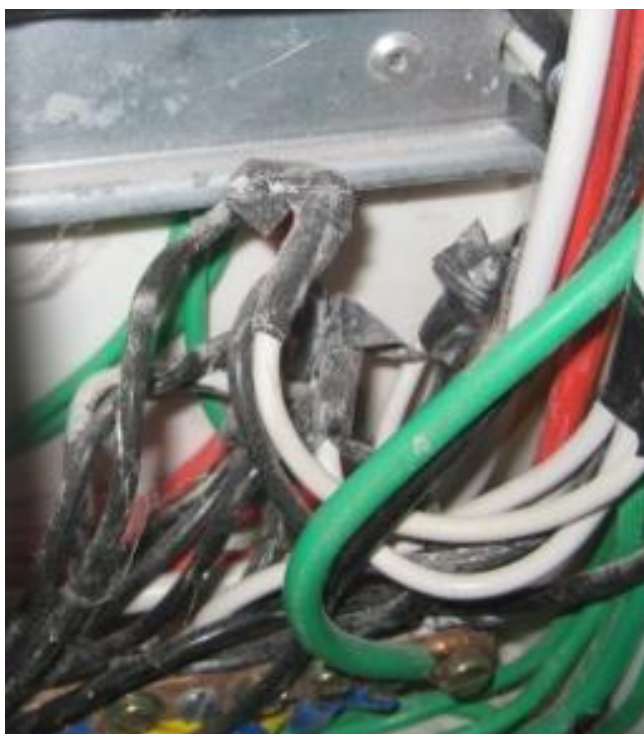
Figura 13 – Detalhe de emenda de condutores de diferentes cores
