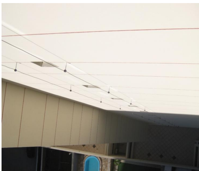
Figura 13 – Descidas do SPDA
