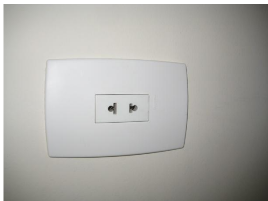
Figura 7 – Tomada do Hall de entrada
