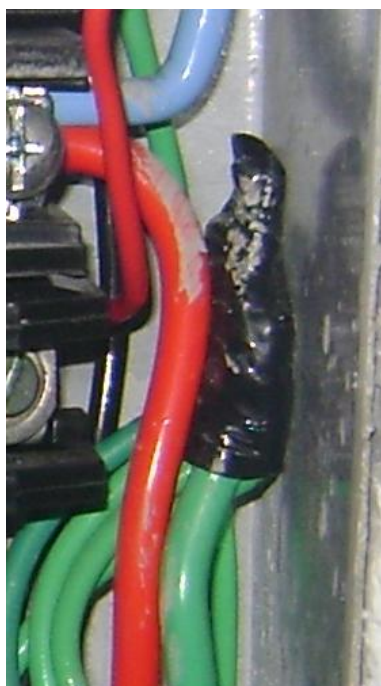
Figura 6 – Emenda entre condutores terra
