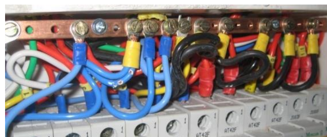
Figura 24 – Barra de neutro do quadro QT-AP1
