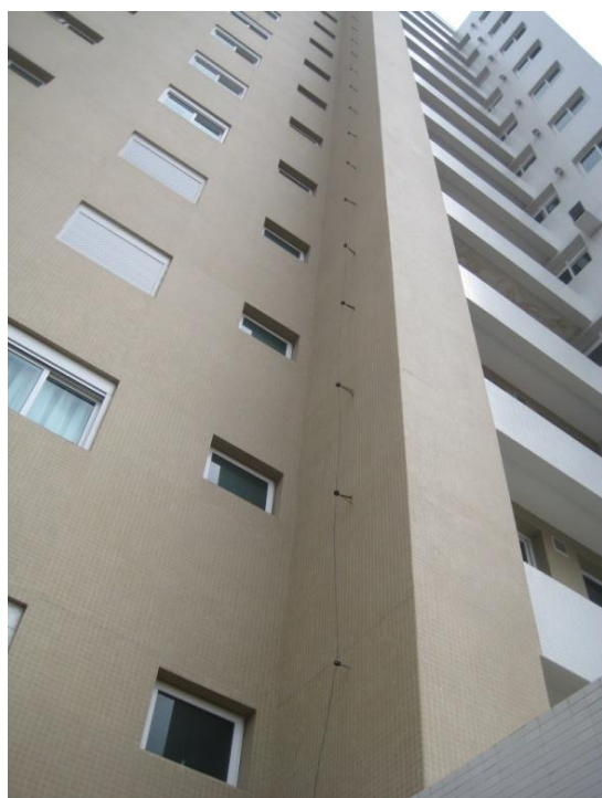
Figura 20 – Descida do SPDA
