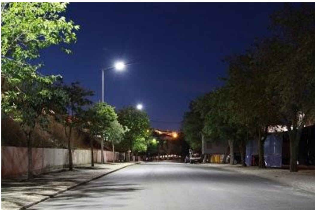
Figura 1 - Iluminação via pública através de luminárias com LEDs. Fonte: Verde Luz, 2011.
