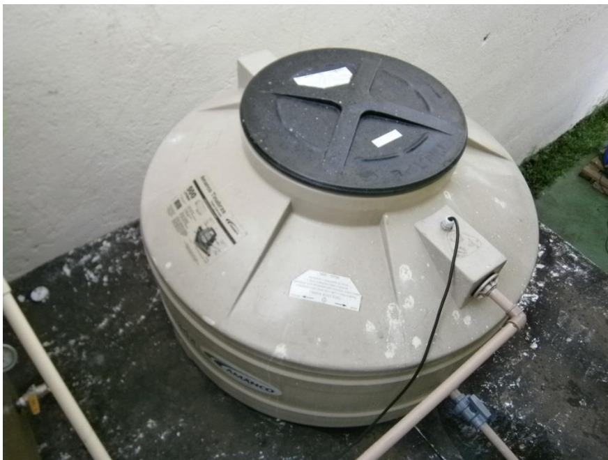
Figura 92 - Caixa d'água que utiliza a água da chuva
