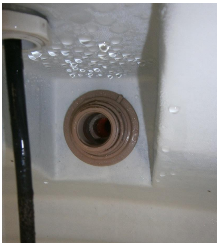
Figura 93 - Tubulação de entrada da caixa d'água
