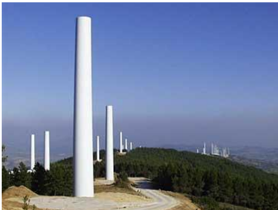
Figura 56 - Torre de concreto
