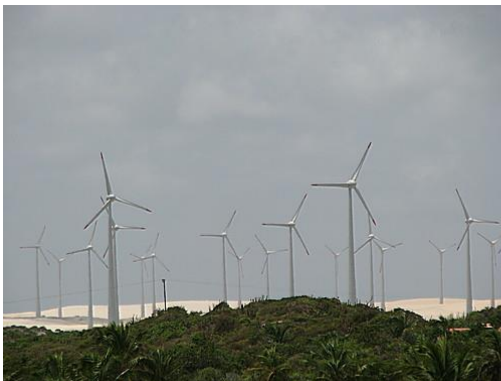
Figura 67 - Usina Eólica Rio do Fogo - Rio do Fogo/RN
