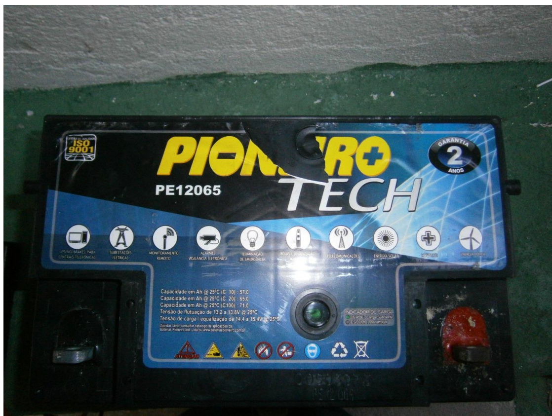
Figura 87 - Bateria que compõe o banco de baterias do SFI
