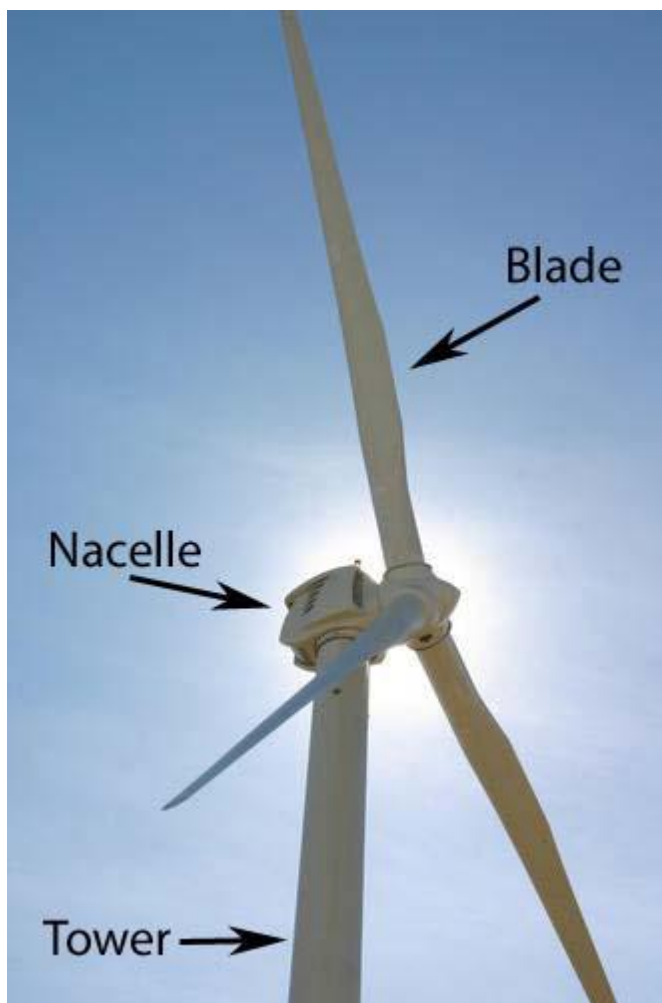
Figura 52 - Componentes básicos de uma turbina eólica. Fonte: ANDERSON (2009)
