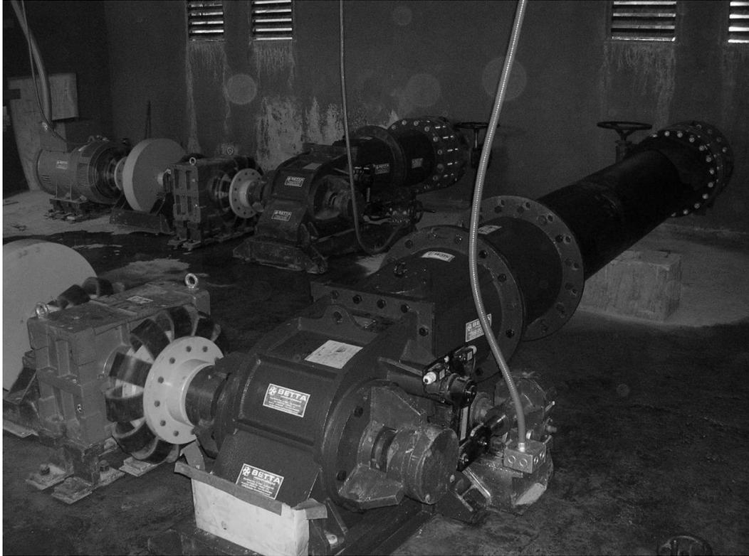
**Figura 18: Duas Turbinas Michell-Banki em Paralelo**
