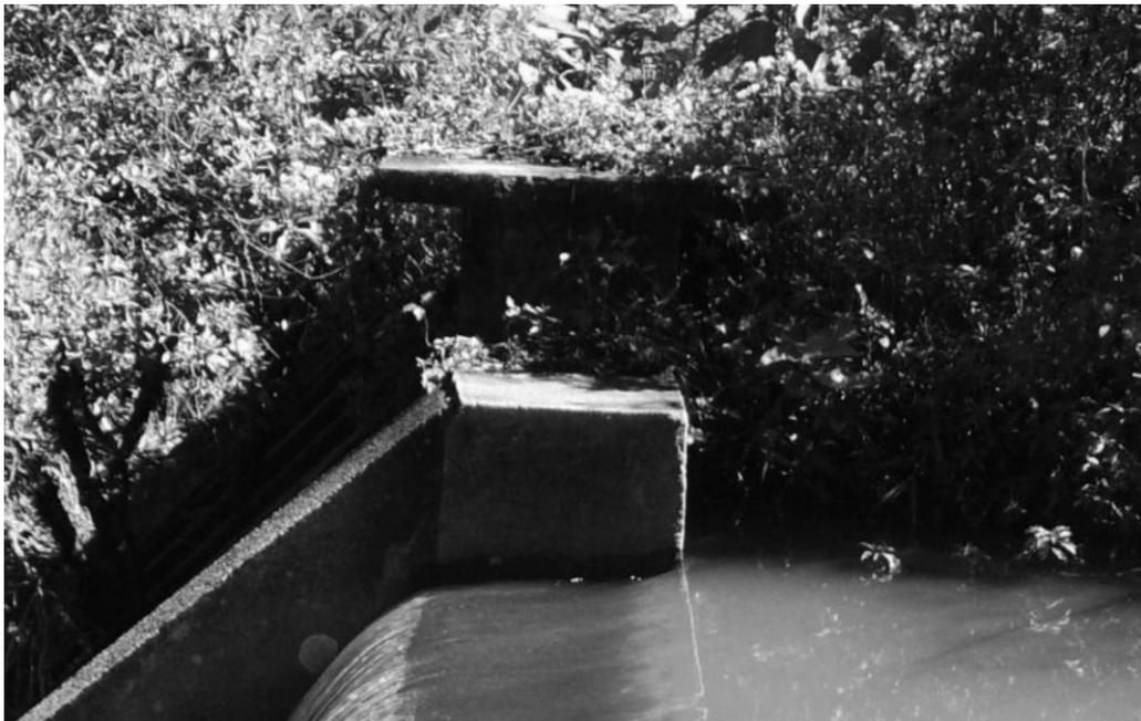
**Figura 10: Tomada d'Água da MCH de Roncador**
