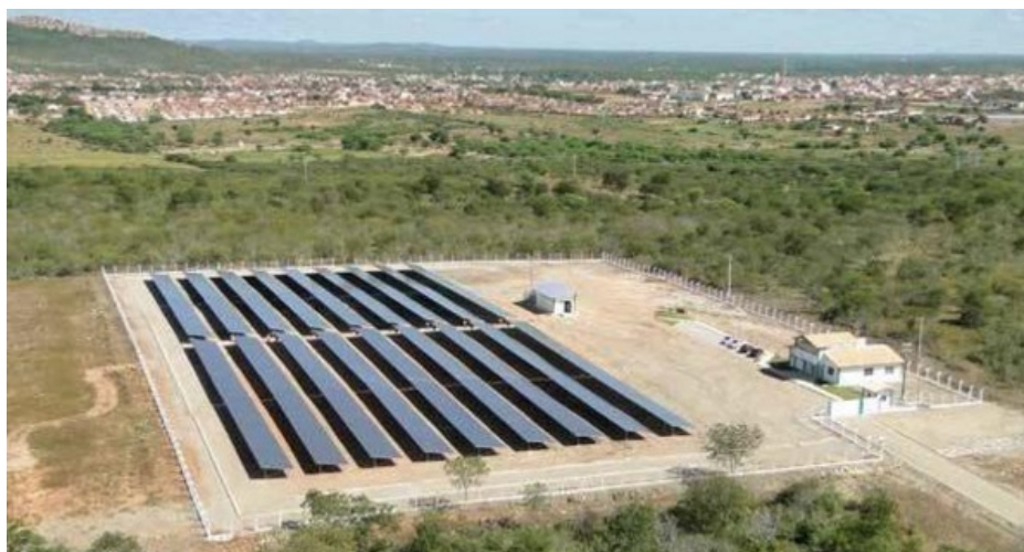
Figura 23 - Usina solar de 1 MWp em Tauá – Ceará.
