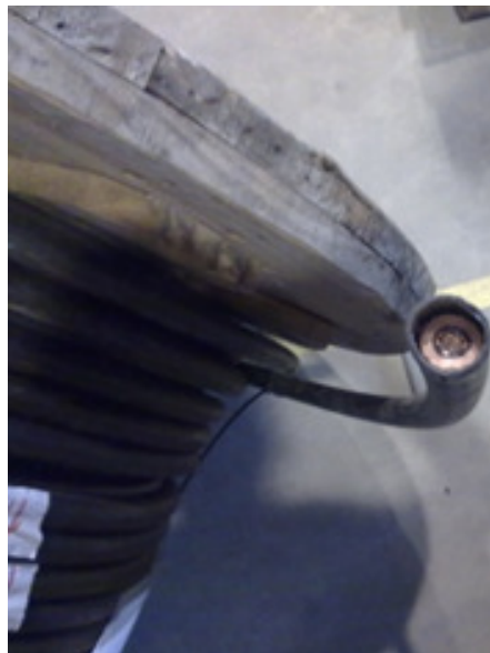
Figura 61 - Extremidade a ser isolada.
