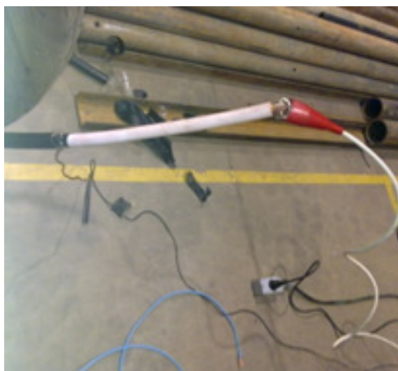
Figura 63 - Terminais ligados ao cabo.
