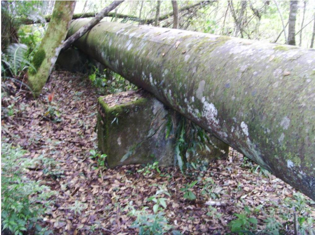
Figura 49 – Bloco de apoio ou sela
