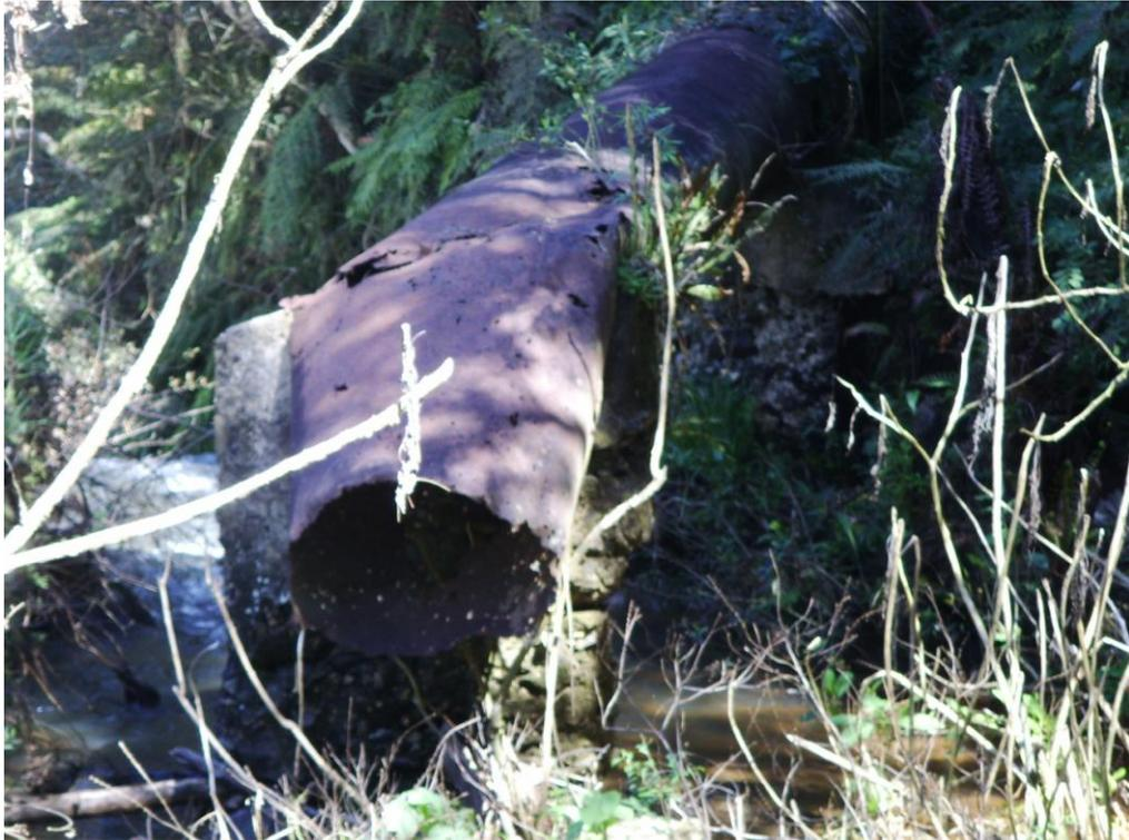
Figura 43 – Conduto forçado existente na hidrelétrica Roncador
