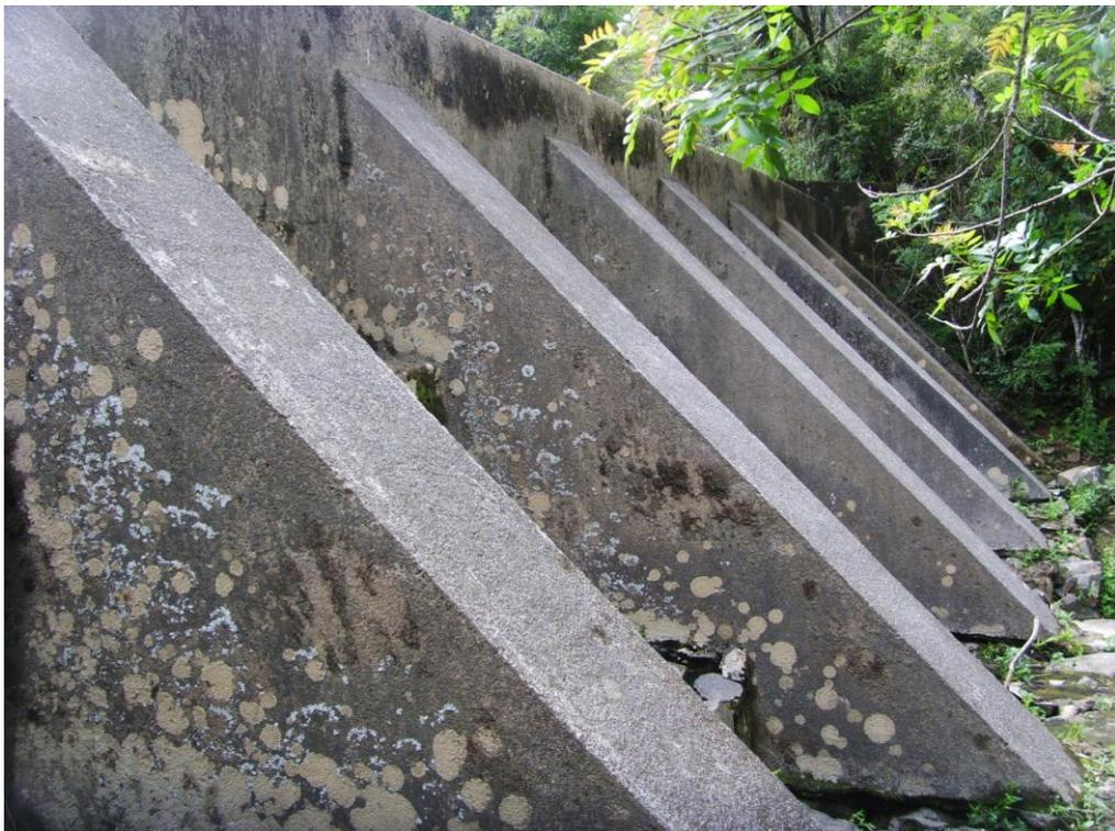
Figura 31 – Contrafortes de concreto
