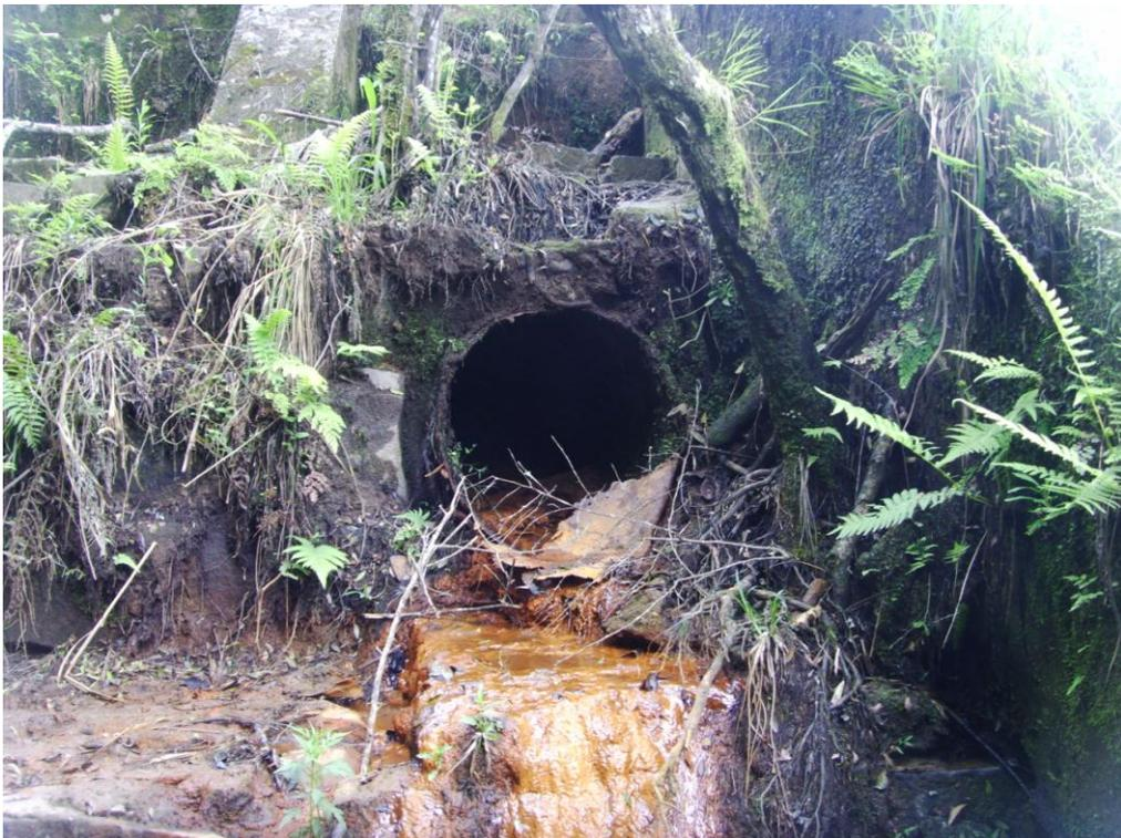
Figura 40 – Tubulação forçada na saída da tomada d'água
