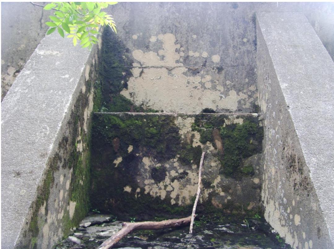
Figura 34 – Erosão na barragem da hidrelétrica Roncador
