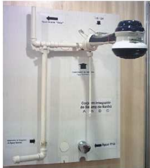
Figura 22 - Chuveiro interligado com sistema ASBC Fonte: SOCIEDADE DO SOL, 2009
