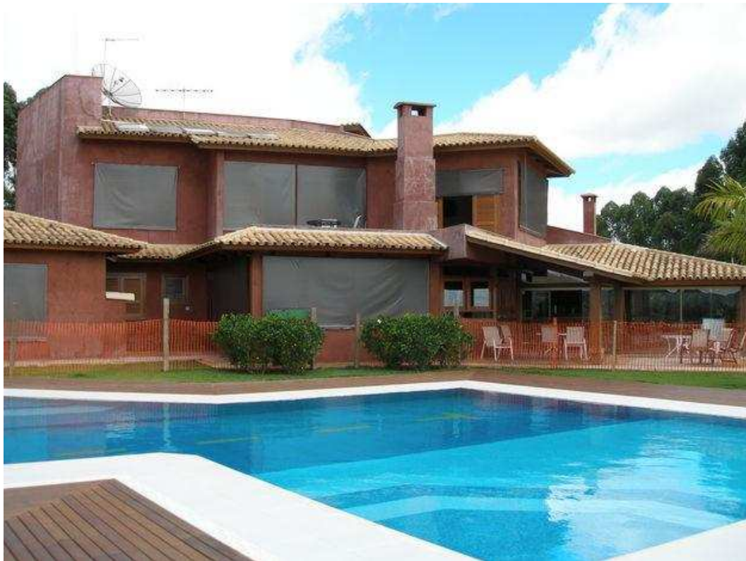
Figura 18 - Aquecedor solar em casa de alto padrão em BH (MG) FONTE: BHSolar, 2011
