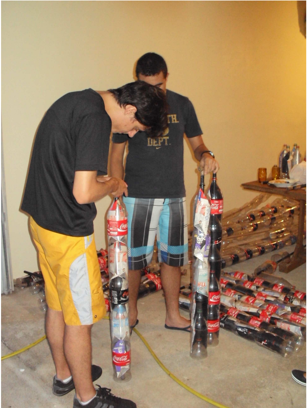
Figura 43 - Encaixe das garrafas PET nos canos de PVC Fonte: ARQUIVO PESSOAL, 2011
