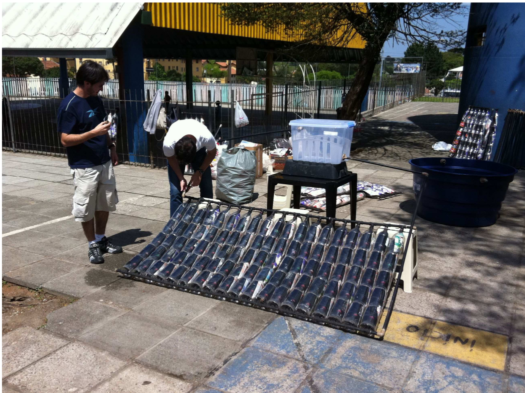
Figura 49 - Instalação do aquecedor solar na escola Fonte: ARQUIVO PESSOAL, 2011
