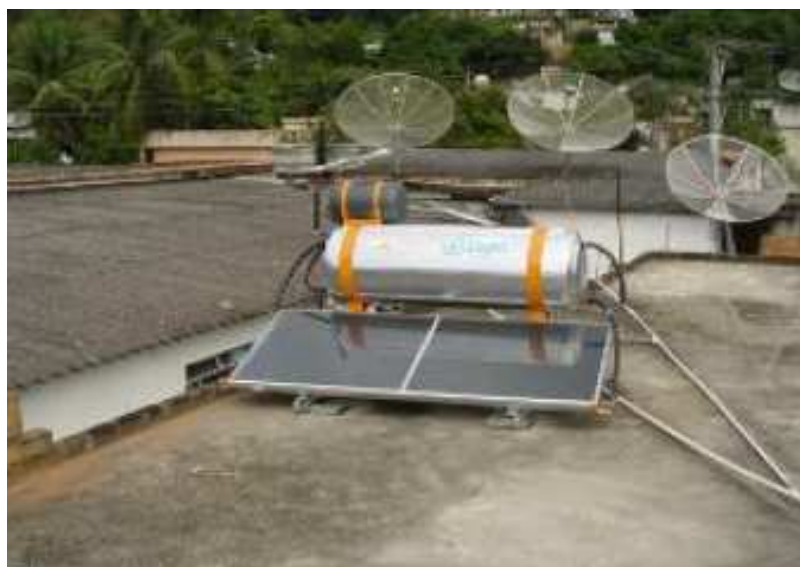
Figura 14 - Sistema acoplado de termossifão Fonte: SOLETROL, 2008
