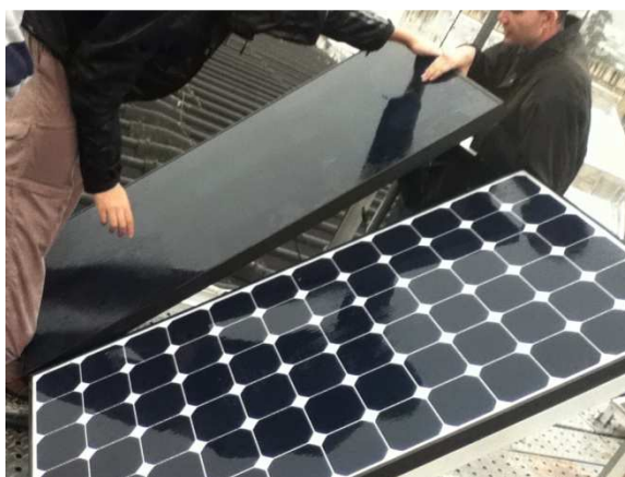
Figura 34 - Posicionamento do segundo módulo fotovoltaico.
