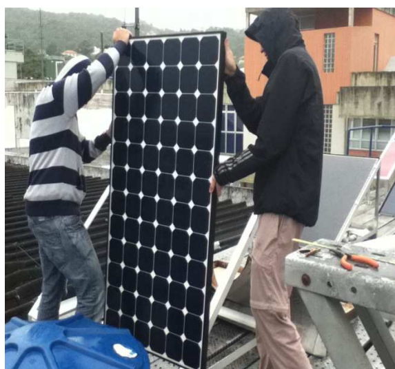
Figura 32 - Módulo fotovoltaico sendo posicionado sobre o perfil de alumínio.
