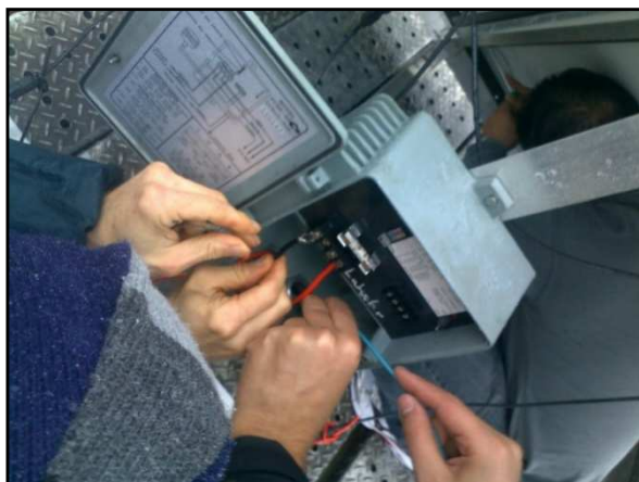
Figura 38 – Conexão das ligações do sistema fotovoltaico.
