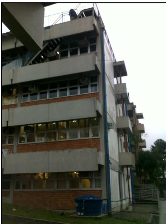
Figura 43 – Vista da edificação onde está instalado o sistema de bombeamento
