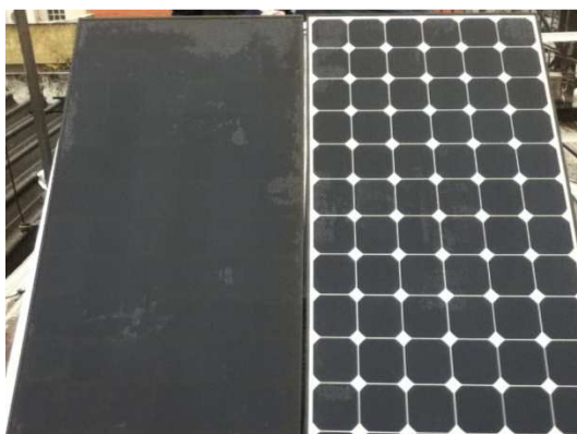
Figura 35 - Módulos fotovoltaicos instalados
