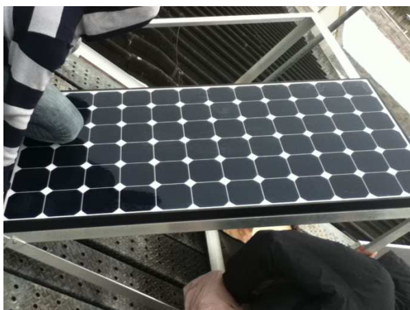
Figura 33 - Ajuste da inclinação do módulo.
