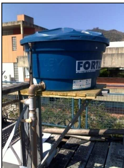
Figura 40 – Caixa de água para armazenamento.
