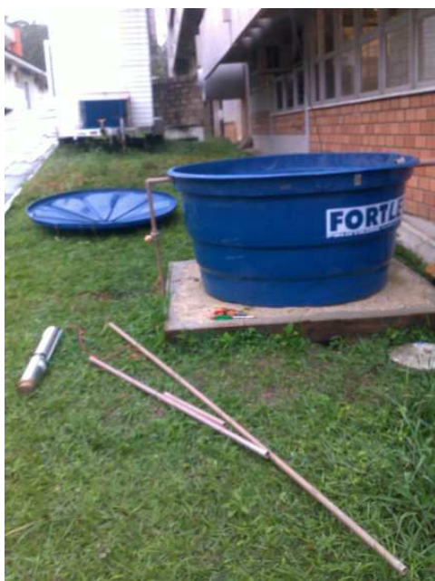
Figura 41 - Montagem da bomba na caixa de água inferior.
