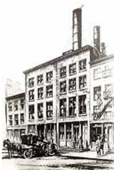
Figura 4 – Primeira usina de geração de energia, em Pearl Street, Nova Iorque em 1882 criada por Thomas Edison, fonte: World of Energy (2011)
