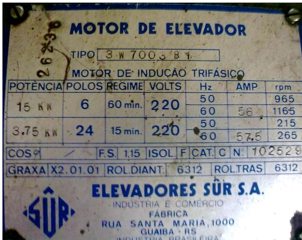
Figura 29 - Placa de identificação do motor do elevador
