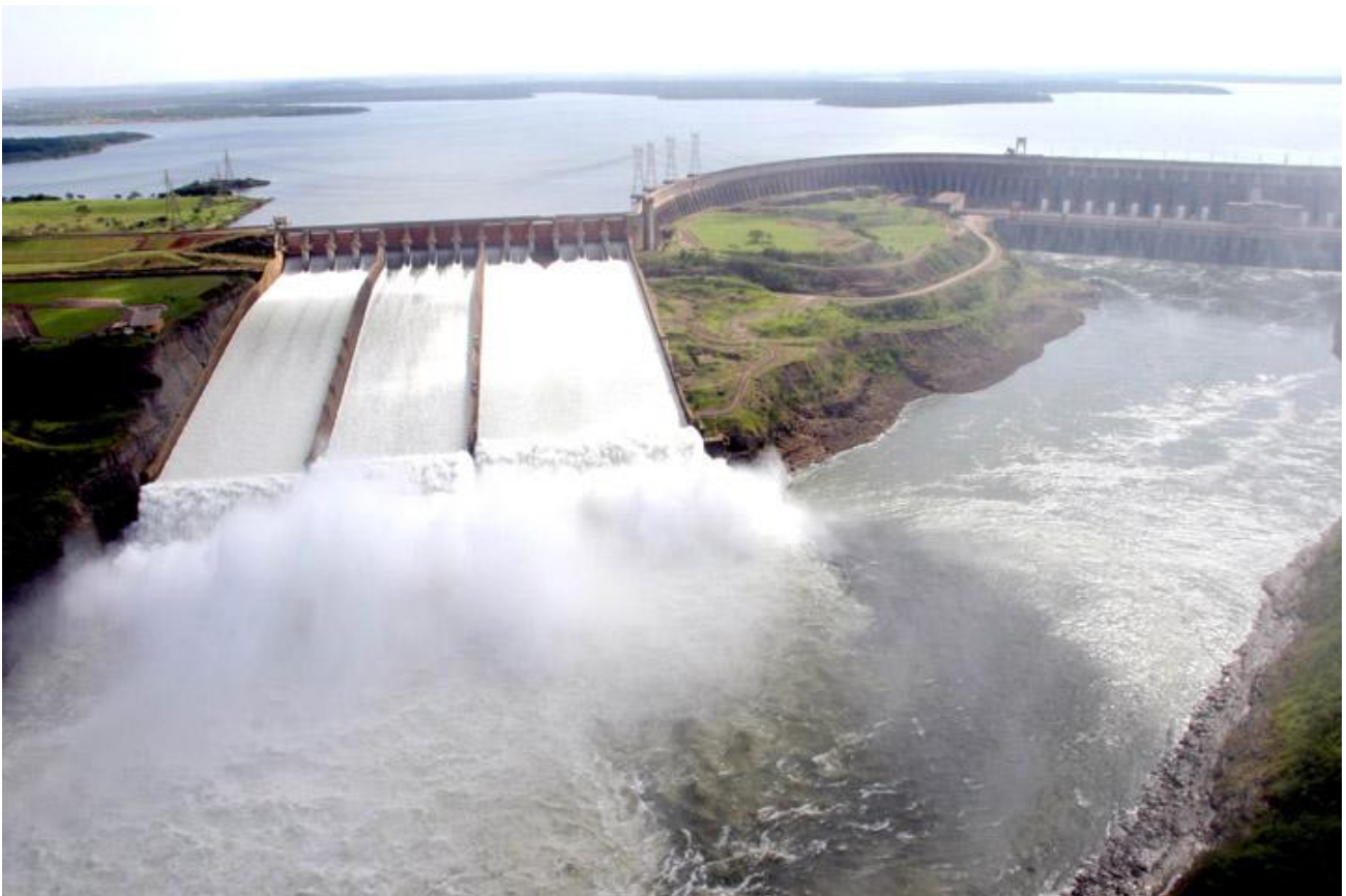
Figura 17 - Vertedouro de Itaipu Fonte: Itaipu, 2011.
