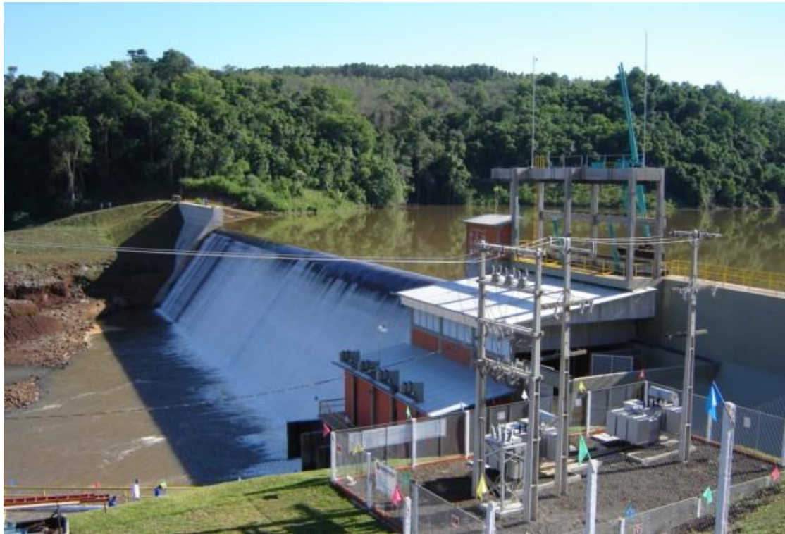
Figura 18 - PCH Santo Antônio Fonte: Hacker, 2011.
