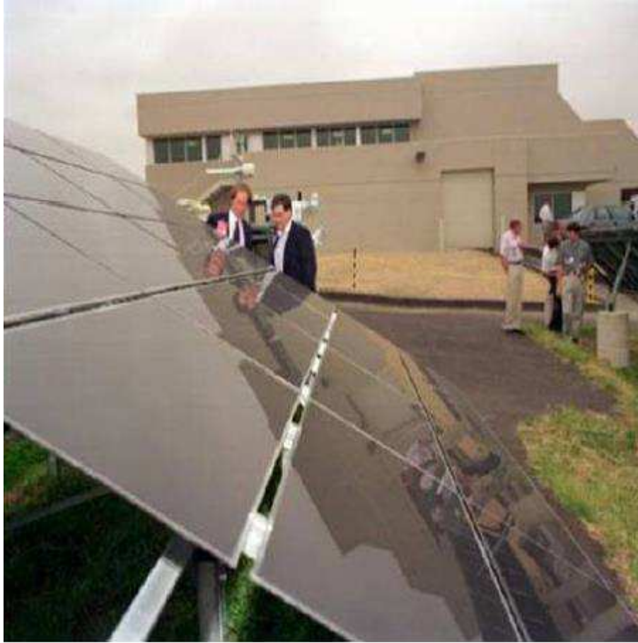
Figura 16 – Módulos fotovoltaicos de CdTe em aplicações arquitetônicas. Fonte: RÜTHER (2004).
