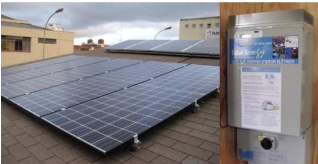
Figura 27 – Painel FV e inversor do EV da UTFPR Fonte: JUNIOR; JUNIOR; TIEPOLO (2014).
