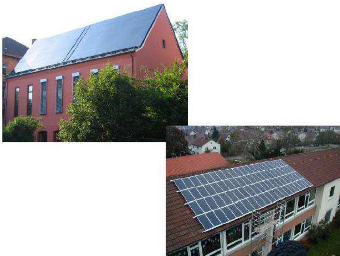
Figura 17 – Módulos fotovoltaicos de CIGS em aplicações arquitetônicas. Fonte: RÜTHER (2004).
