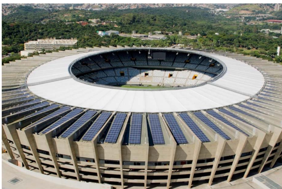
Figura 10 - Cobertura do Mineirão com módulos fotovoltaicos Fonte: CEMIG, 2014.
