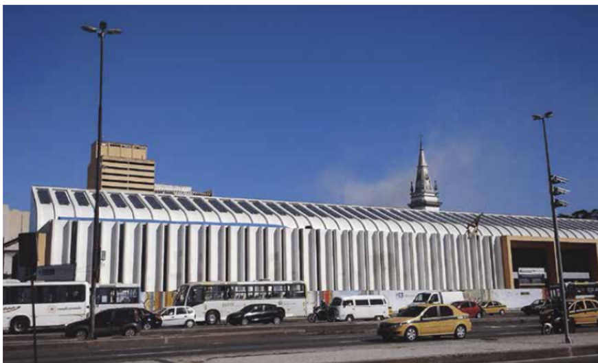
Figura 11 - Sistema Fotovoltaico instalado na Biblioteca Pública do Rio de Janeiro Fonte: Light, 2012.
