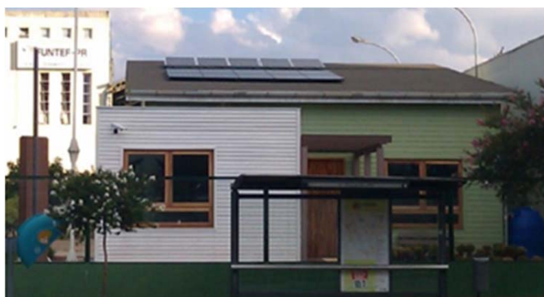
Figura 20 - Fachada do Escritório Verde da UTFPR
