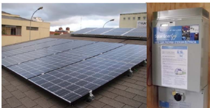
Figura 21 - Módulo Fotovoltaico e Inversor Monofásico do Escritório Verde Fonte: URBANETZ et al., 2014.
