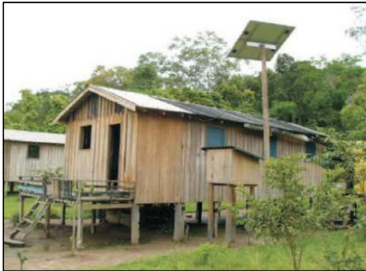
Figura 3: Sistema Fotovoltaico Domiciliar no Amazonas Fonte: (Mocelin, 2007)
