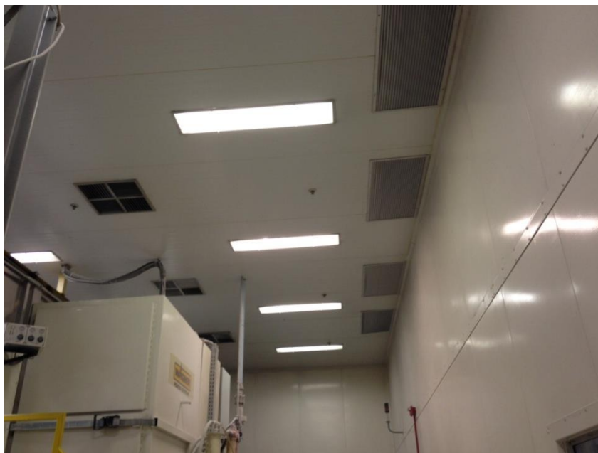
Figura 18 - Saídas de ar dimensionadas para o correto fluxo de ar na cabine de pintura.
