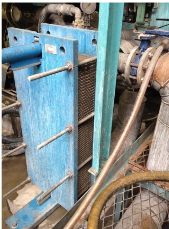
Figura 12 - Trocador de calor do tipo colmeia.
