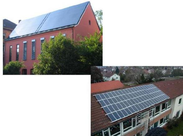
**Figura 18 - Módulos fotovoltaicos de CIGS em aplicações arquitetônicas.**
