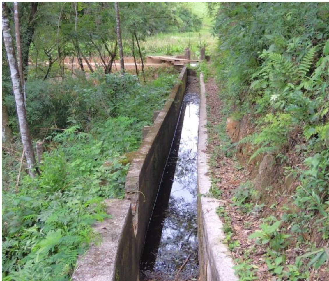
Figura 10 – Canal de adução Usina Rancharia Fonte: Autoria própria.
