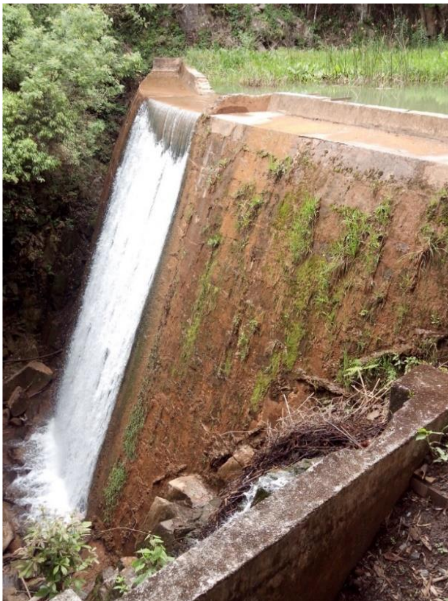
Figura 11 – Barragem da Usina Rancharia Fonte: Autoria própria.
