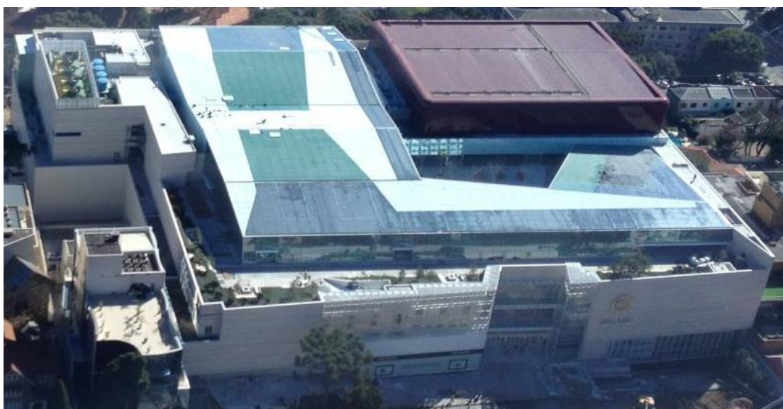
Figura 33 – Detalhe da cobertura shopping A . Fonte: Google Earth (2014).
