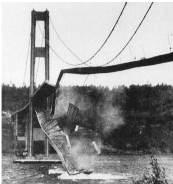
Figura 2.9 Após ter entrado em ressonância a estrutura da ponte não aguentou e ela ruiu. Fonte: (HECHT, 1994)
