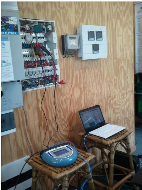
**Figura 29 – Equipamento de medição conectado ao QGBT**
