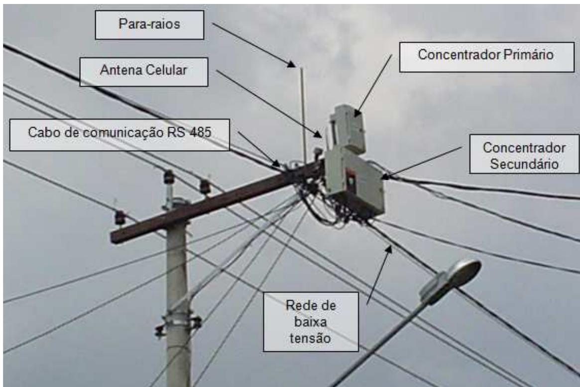
**Figura 64 - Rede DAT com SGP+M**
