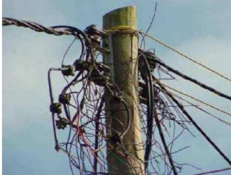
**Figura 16 - Furto de Energia na Rede de Baixa Tensão.**
