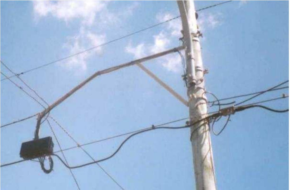
**Figura 60 - Barreira física para proteção da rede BT**
