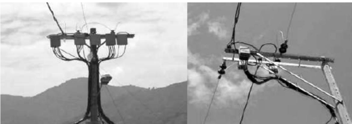
**Figura 61 - Barreira física para proteção da rede BT**
