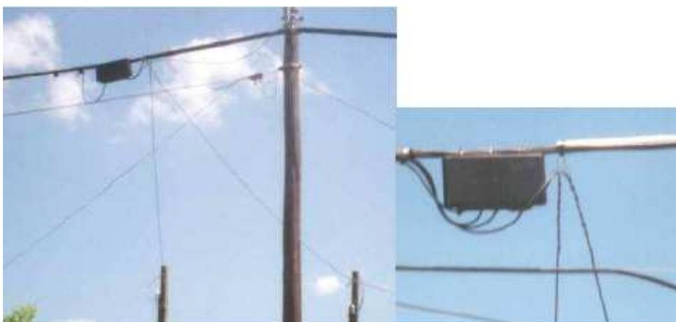
**Figura 59 - Proteção da baixa tensão através de uma barreira física.**
