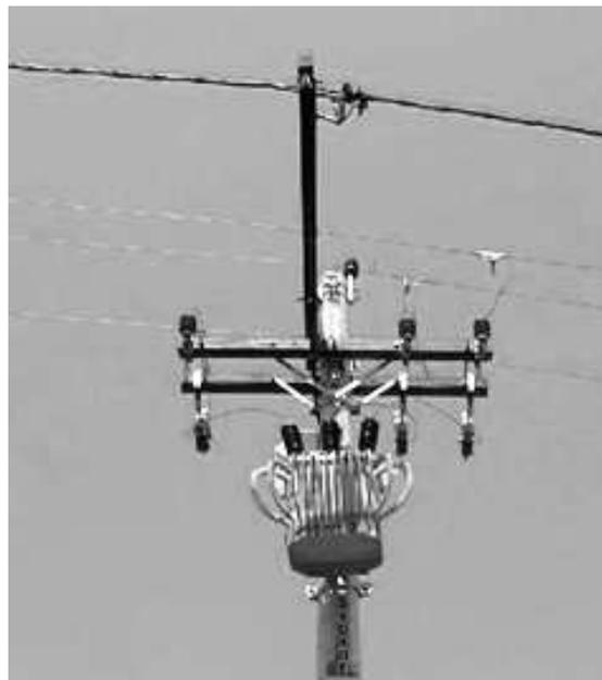
**Figura 43 - Poste com transformador e rede com padrão DAT.**
