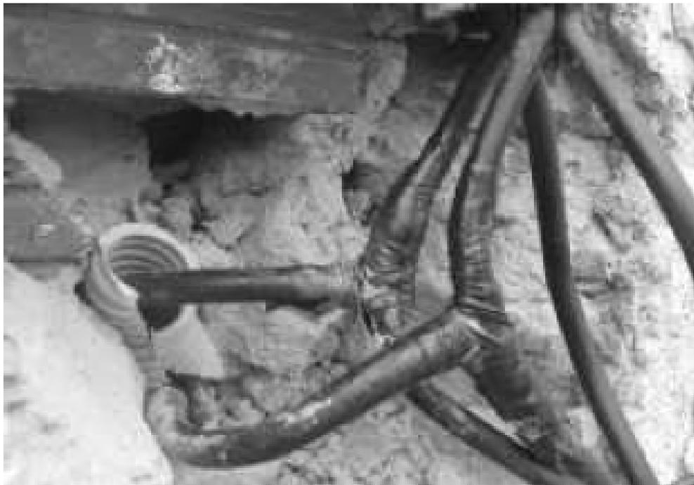
**Figura 13 - Desvio de energia escondida na parede da casa**
