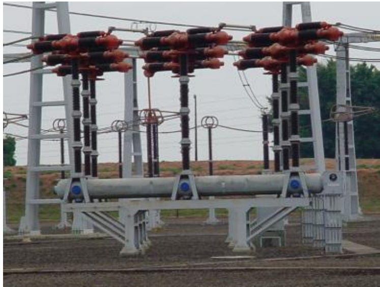
Figura 2.9 - Modelo de disjuntor a ar comprimido – Fabricação Alstom. Fonte: W Service (2004).
