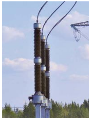
Figura 2.10 - TP capacitivo. Fonte: Artech (2015).
