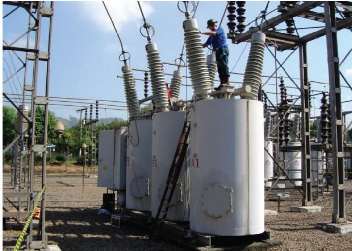
Disjuntor GVO de Alta Tensão Westinghouse
