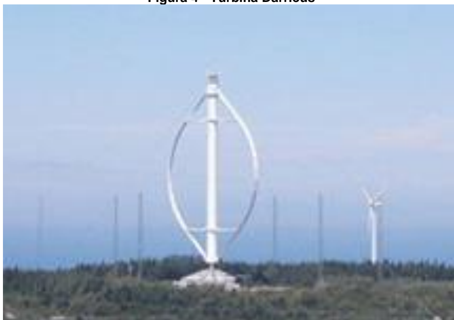
Figura 4 - Turbina Darrieus
