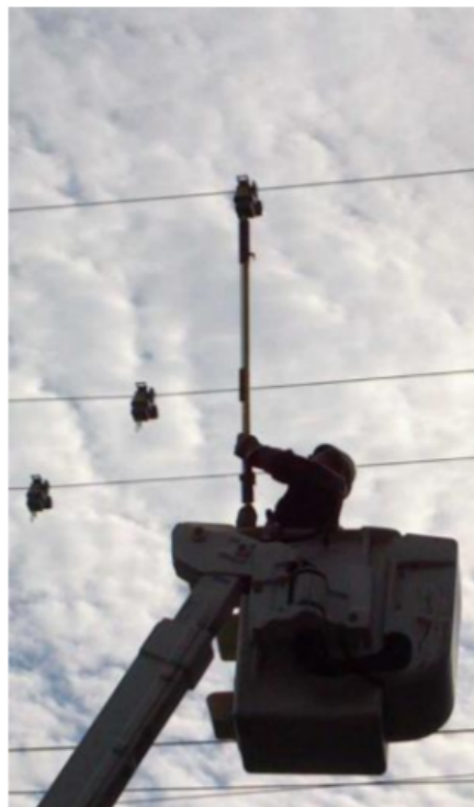
FIGURA 8: Instalação de IF no cabo
