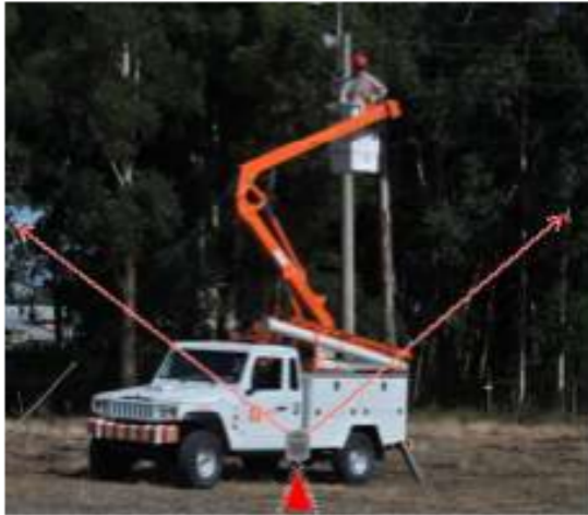
FIGURA 50: Exemplo da atuação da equipe com cesto aéreo
