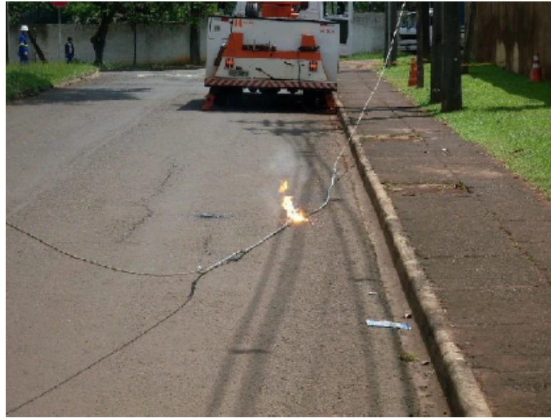
FIGURA 12: Curto-circuito fase terra sobre asfalto
