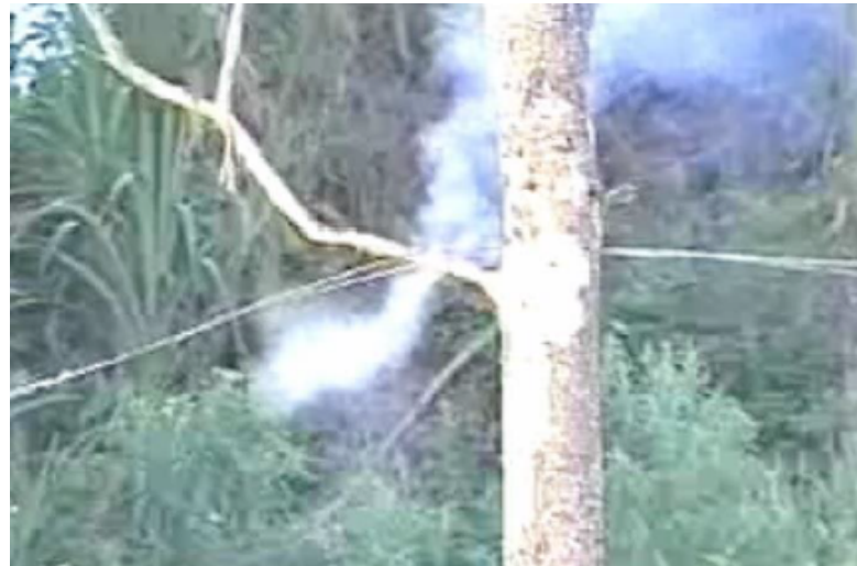
FIGURA 11: Curto-circuito fase terra sobre cabo de árvore
