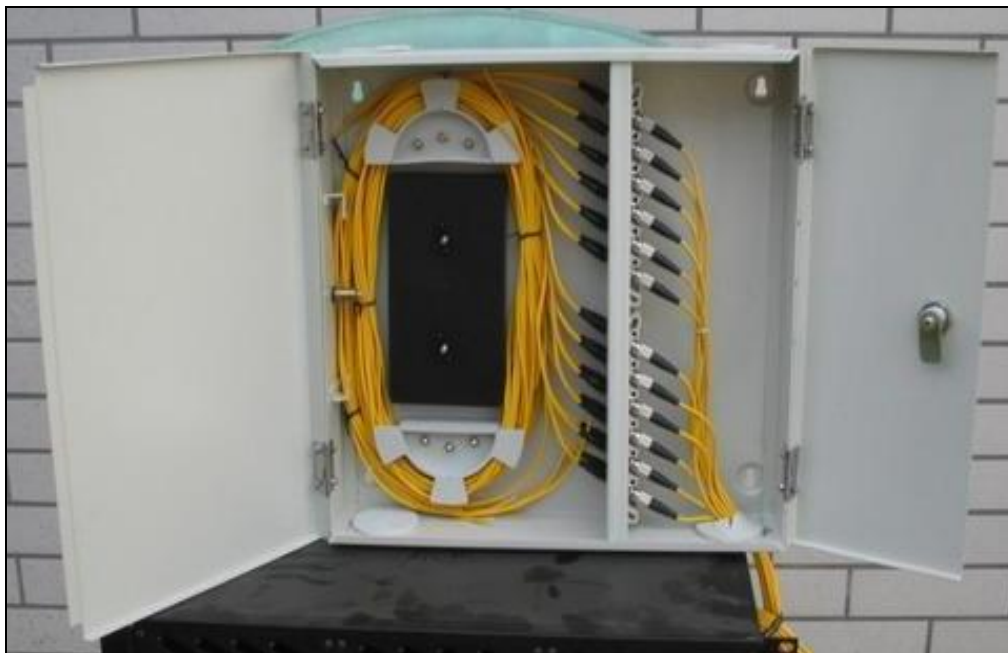
Figura 7- Caixa de parede para fibra ótica Fonte: TE (2014)
