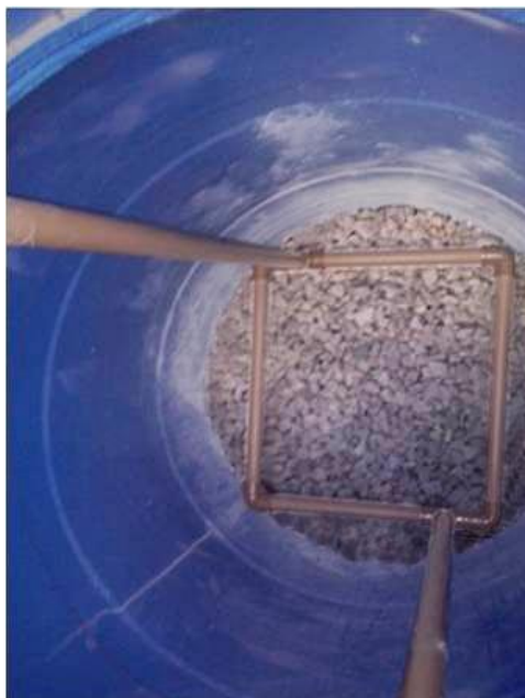
Figura 35 – Aplicação da primeira camada com brita comum.
