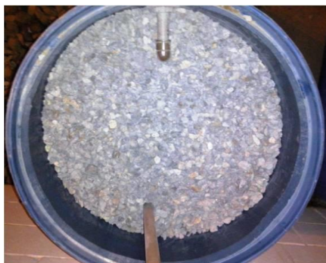
Figura 38 – Aplicação da quarta camada com brita comum
