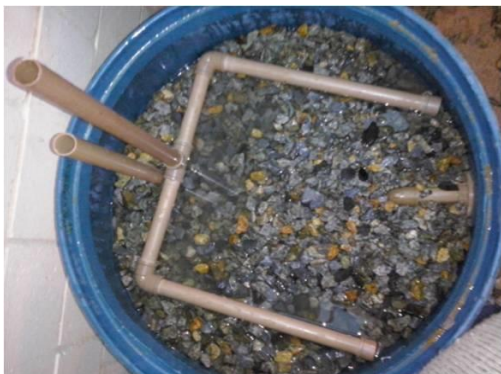
Figura 39 – Montagem da tubulação de distribuição na entrada
