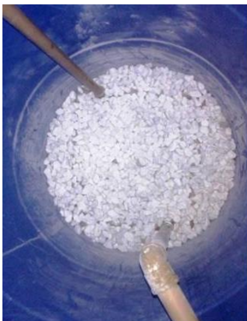
Figura 36 – Aplicação da segunda camada com brita calcária
