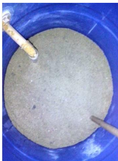
Figura 37 – Aplicação da terceira camada com areia
