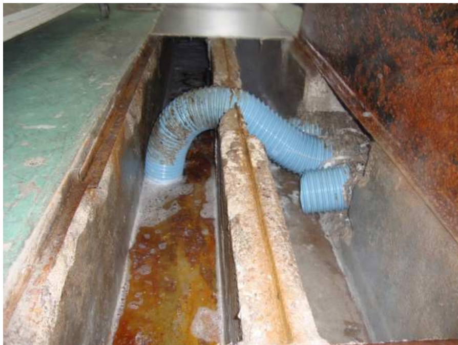
Figura 14- Canaletas separadas para coleta de efluente.
