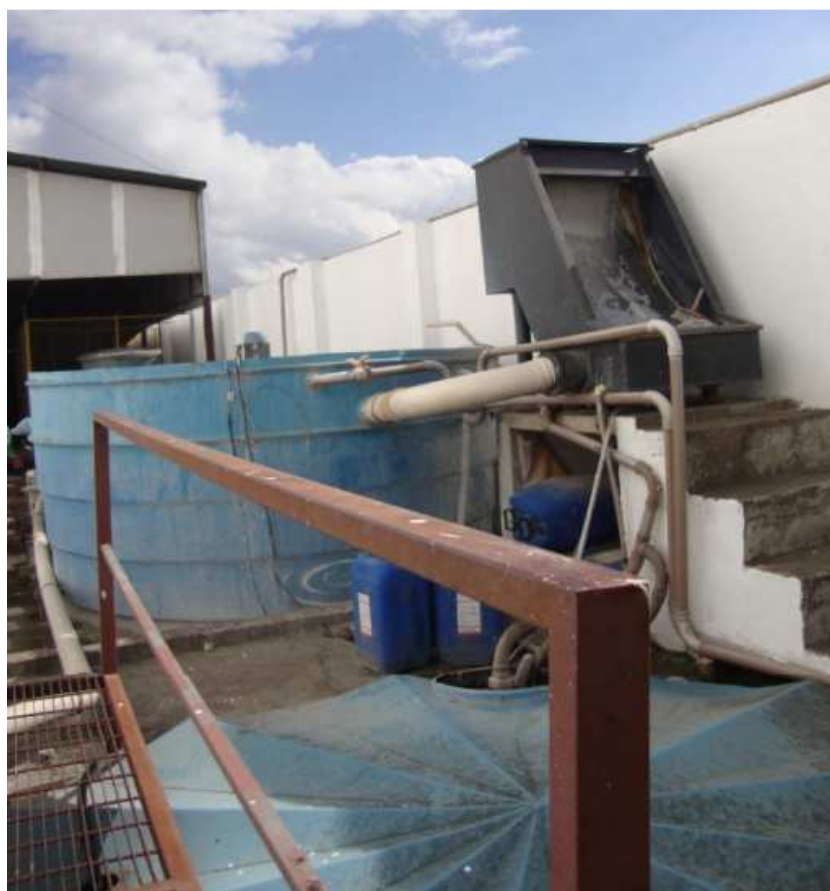
Figura 12 – Peneira estática à direita da imagem;
