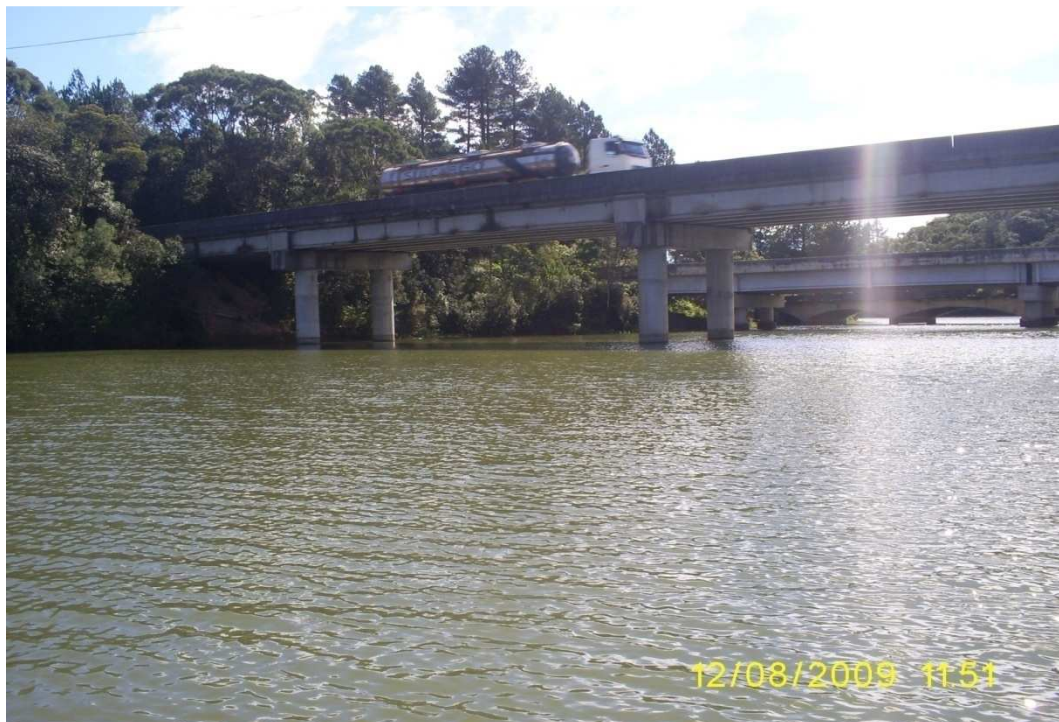
FIGURA 11. SEGUNDA PONTE QUE CRUZA O RESERVATÓRIO. LOCAL DE COLETA DOS PONTOS DENOMINADOS P7 E P8.
