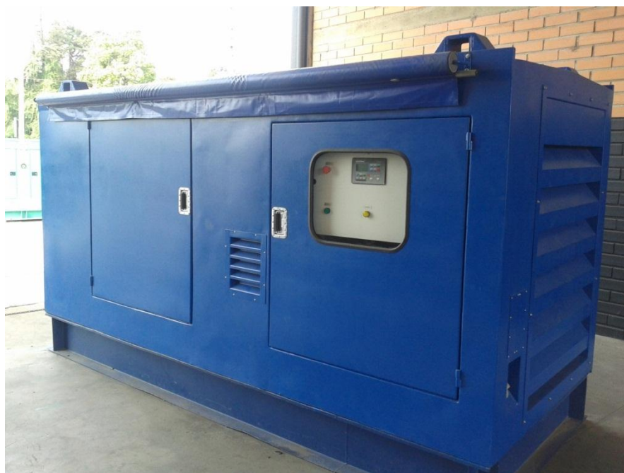
Figura 30 - GMG após montagem dos componentes principais Fonte: Autoria própria.
