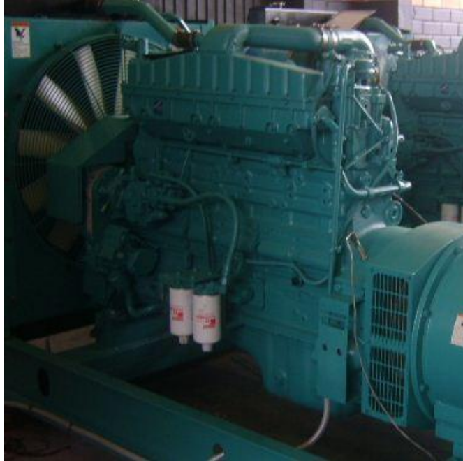
Figura 1 - Motor Diesel Cummins Série NTA 855 Fonte: Autoria própria.
