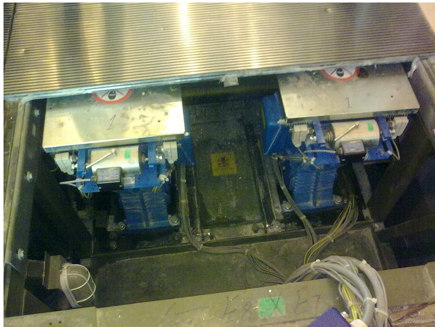
Figura 41 – Casa de máquinas localizado no patamar superior Fonte: Autoria própria.
