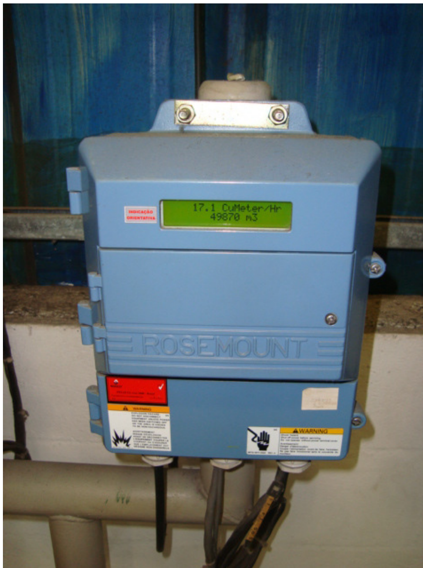
Figura 13 - Conversor eletromagnético de vazão modelo 8712/87321 Fonte: Renault do Brasil (2010)
