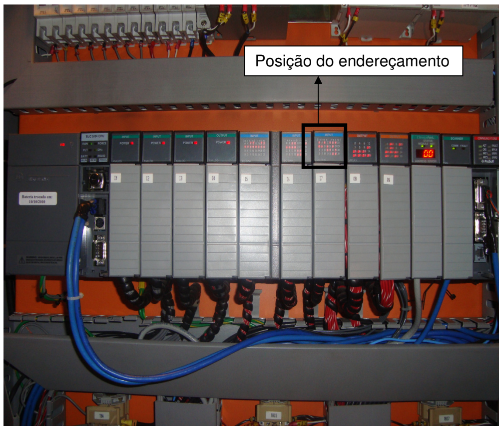
Figura 31 – Painel elétrico com um CLP Fonte: Renault do Brasil (2010)
