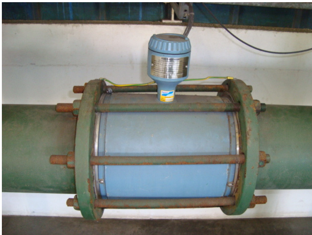
Figura 12 - Medidor Eletromagnético da marca Rosemount Fonte: Renault do Brasil (2010)
