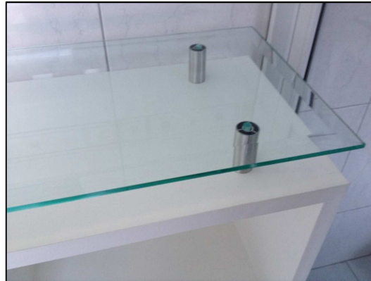
Figura 61: Instalação do vidro. Fonte- Arquivo da autora, 2014.
