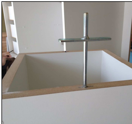
Figura 84: Colocação do pino invisível no nicho. Fonte- Arquivo da autora, 2014.
