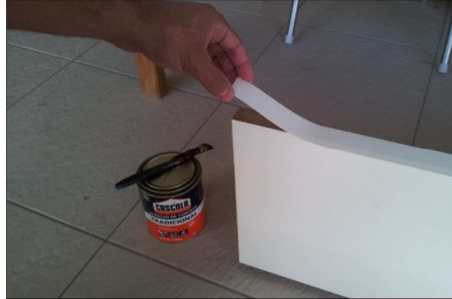
Figura 48: Aplicação da fita de borda nas chapas.
