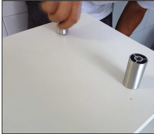
Figura 60: Instalação dos espaçadores (2). Fonte- Arquivo da autora, 2014.
