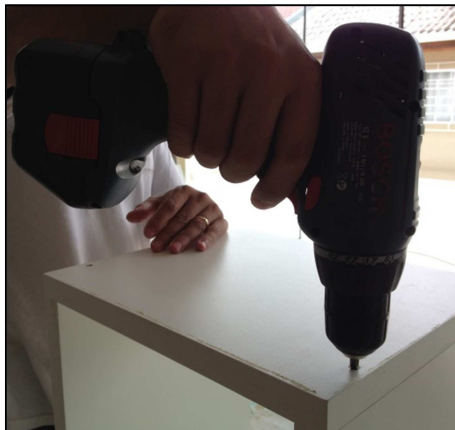
Figura 81: Fixação do nicho. Fonte- Arquivo da autora, 2014
