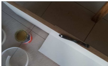
Figura 46: Aplicação de cola nas bordas das chapas . Fonte- Arquivo da autora, 2014
