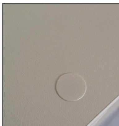
Figura 62: Instalação do tapa furo. Fonte- Arquivo da autora, 2014.
