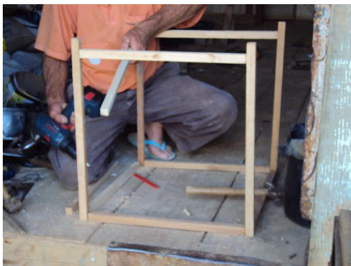
Figura 36– Encaixe das travessas estruturais Fonte: O Autor
